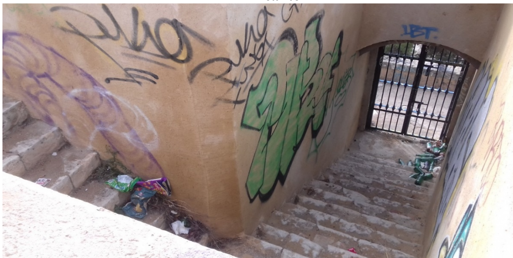
Figura nº 9. Detalle del escaso mantenimiento del castillo de San Fernando, Alicante
