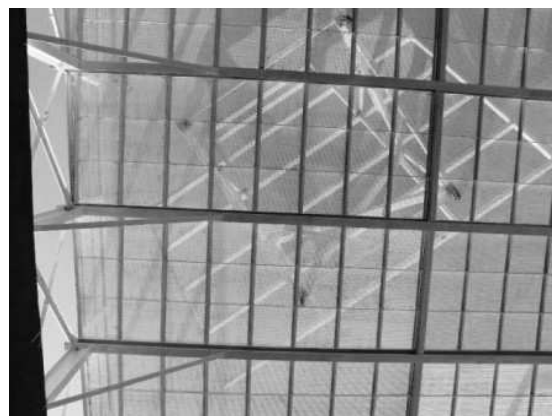
Figura 2: Imagen desde el nivel cero de la estructura terminada, campus de la UTN-FRBA
