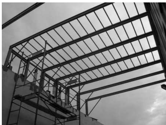
Figura 1: Construcción de estructura de la plataforma para soporte del banco de ensayos en perfiles de hierro
