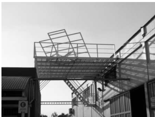
Figura 3: Acceso a la plataforma desde el interior del Laboratorio de Ingeniería Civil – FRBA - UTN
