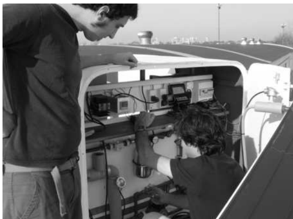
Figura 6: Ajuste de caudal en el cuadro hidráulico para ensayo de rutina de colector con agua
