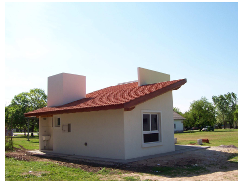
Figura 4: Foto Fachada Sur - Este.
