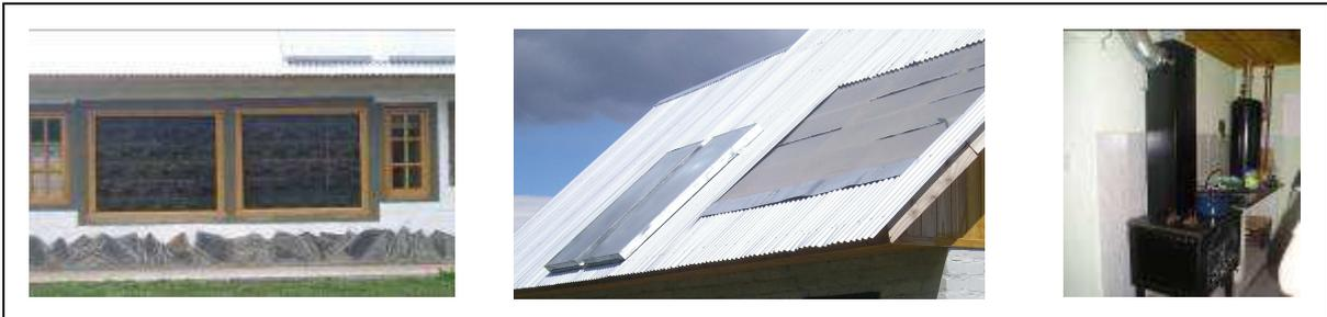
Fotos 4, 5 y 6: Muros colectores-acumuladores; Colectores para calentamiento de agua, Cubiertas de la Vivienda y del Invernáculo; Cocina de chapa y termotanque, ambos a leña y de alta eficiencia.
