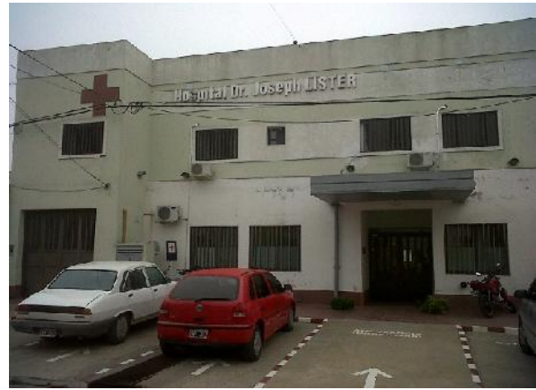
Figura 2. Fachada del hospital Lister
