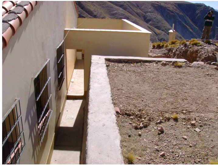
Figura 3: Foto del lugar seleccionado, ya nivelado, para la instalación del colector solar. Atrás se ve el lavadero del colegio donde se colocarán las piletas.
