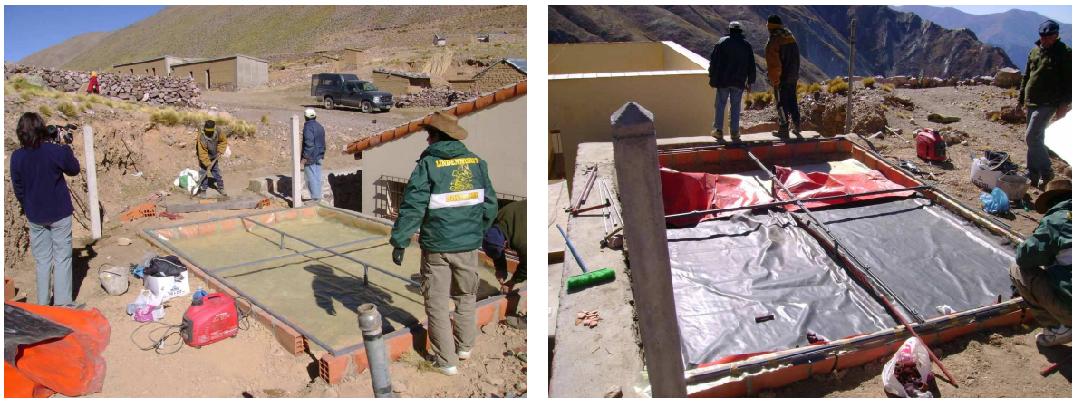
Figura 5.: a) Estructura de caño. b) Colocación de las bolsas de PVC sobre el aislante térmico.
