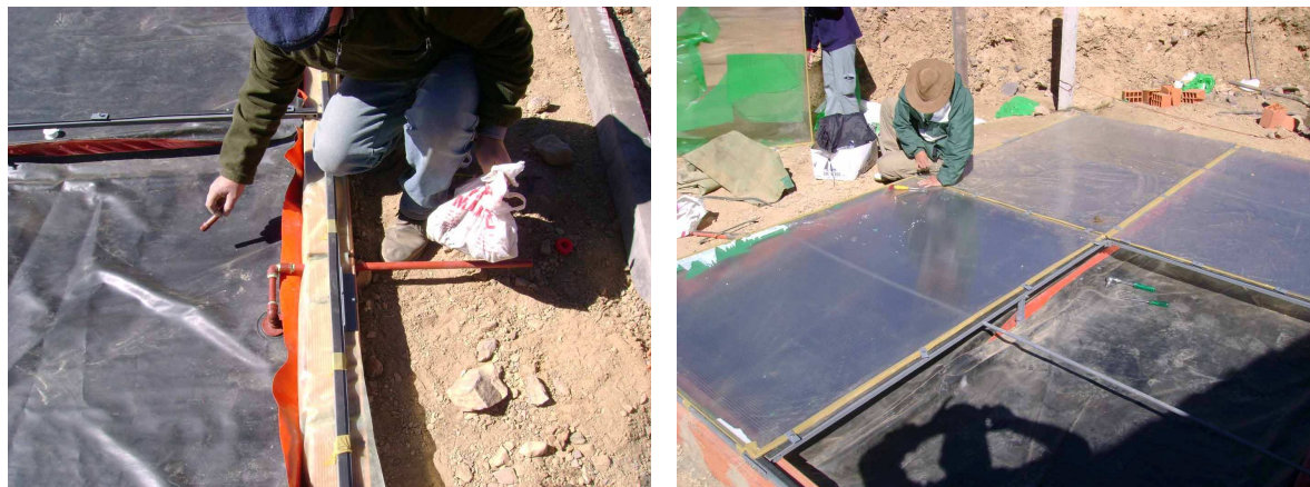
Figura 6.: a) Desborde de las bolsas. b) Colocación cubierta transparente.
