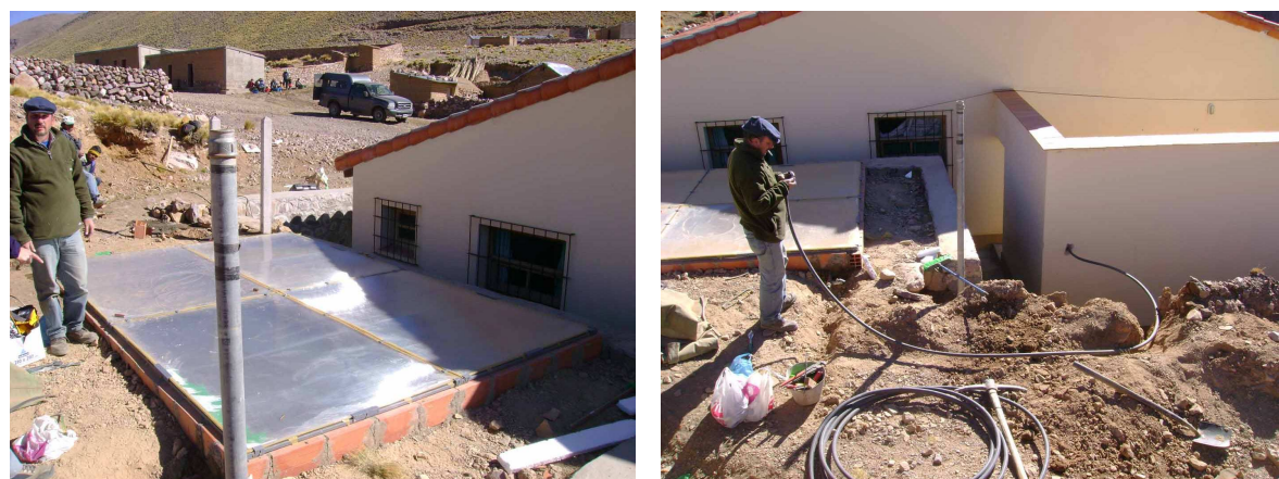
Figura 7.: a) Vista del colector terminado. b) Colocación de cañería para alimentación y distribución del agua caliente.
