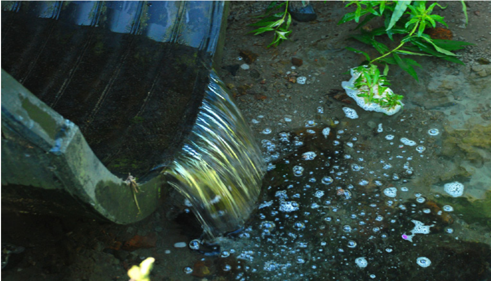
Tierumpujen muutostöiden osalta seurataan nousuesteen korkeutta suhteessa vedenpintaan eri virtaamatilanteissa.
