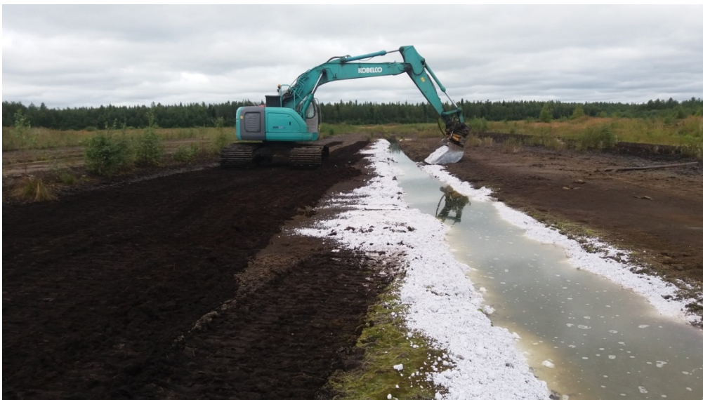
Kuva 48. OPA-sakan levitystä Hangasnevalla. Kuva: Mirkka Hadzic.
