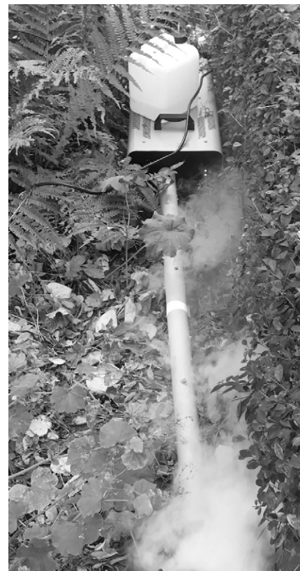
(fig. 44) Test med rökmaskinen på innergården i Bio Centrum. Rören skarvades med hjälp av tejp och monterades på rökmaskinens utblås vilket förlängde rökutsläppet med ca 3 meter. 2019-10-23.
