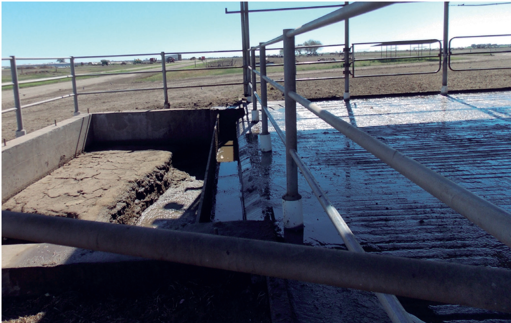
Foto 20: Almacenamiento de estiércol sobre piso de concreto con pendiente para lixiviados hacia la laguna.
