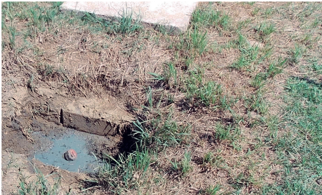
Foto 18: Mala construcción de una perforación con su boca en una depresión que puede favorecer el ingreso de contaminantes.
