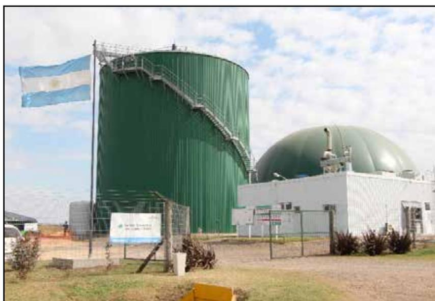
**Ilustración 1.** Vistas del digestor primario (izq.) y del digestor secundario(der.).
