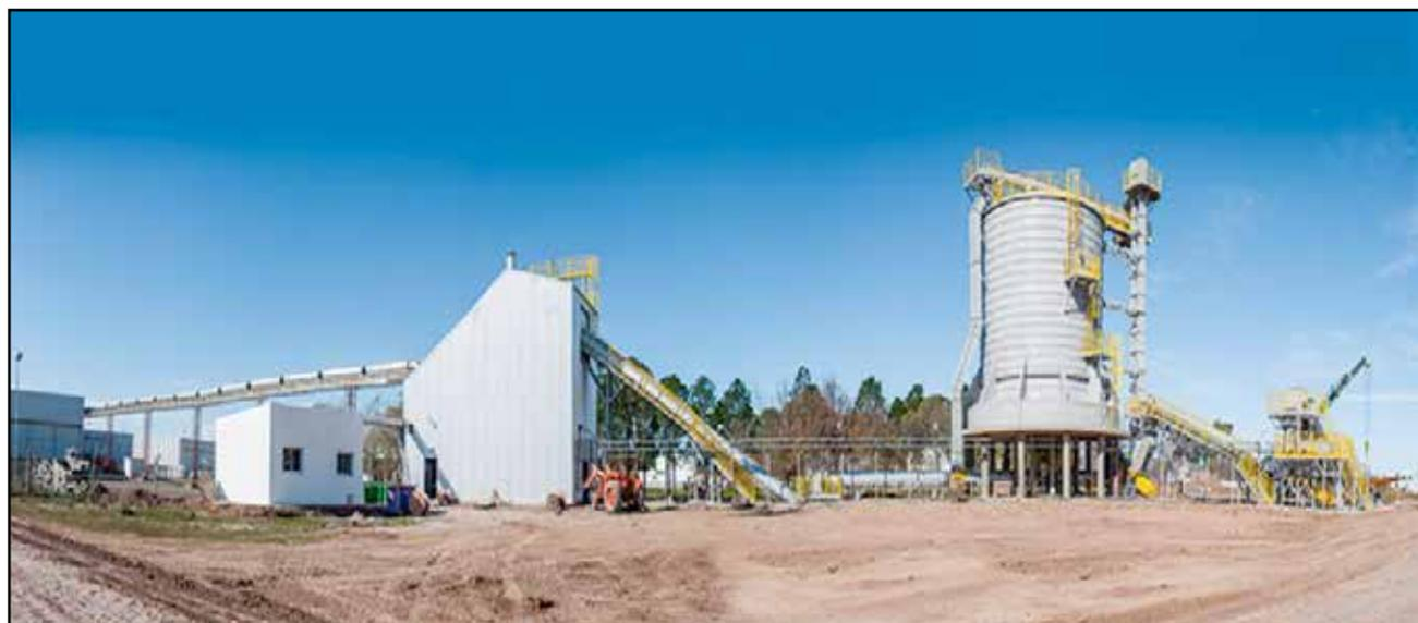
**Ilustración 5.** Silo de biomasa (derecha) y gasificador (centro).
