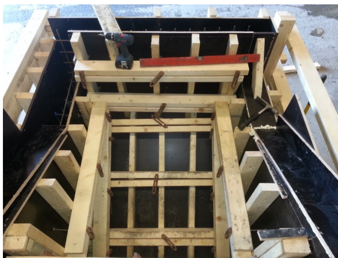
Bilde 12 Sett oven ifra, mot bakvegg. Mangler kun endesteng på venstre side før formen er klar for støp. Bildet viser godt kompleksiteten med forskalingen! (Foto: Morten Austdal)
