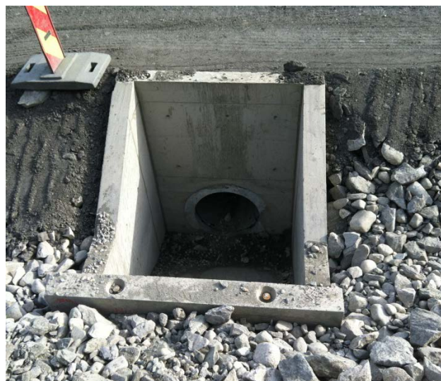
Bilde 17 Viser inntakskonstruksjonen utsatt i terreng (Foto: Morten Austdal og Per Arne Kolseth)
