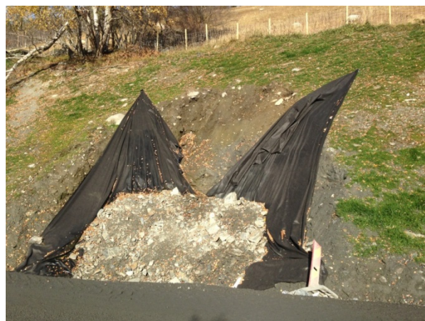
Bilde 8 Viser ekstra terrenginngrepet fremfor stikkrenneinntaket, under utarbeidelse (Foto: Per Arne Kolseth).
