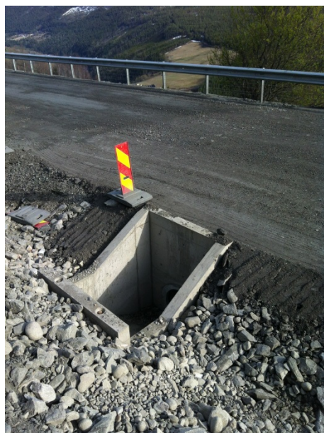
Bilde 17 Viser inntakskonstruksjonen utsatt i terreng (Foto: Morten Austdal og Per Arne Kolseth)
