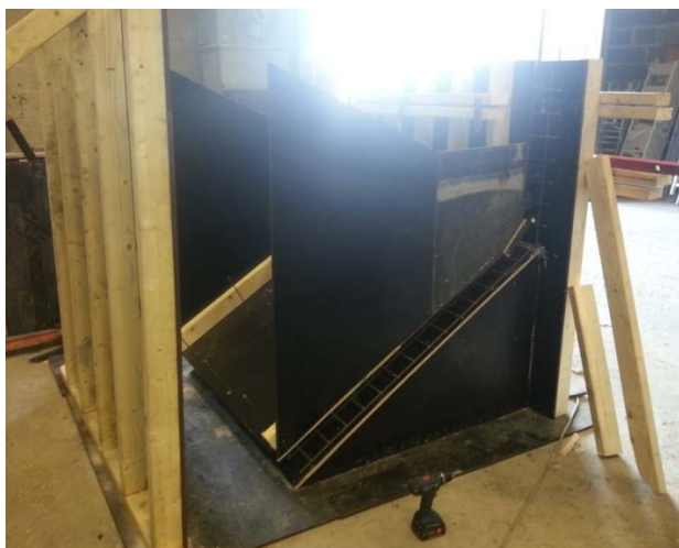
Bilde 9 Inntaksløsningen sett fra siden – fremre kant. Her er den innvendige kassen under montert, mens den over er under bygging. (Foto: Morten Austdal)
