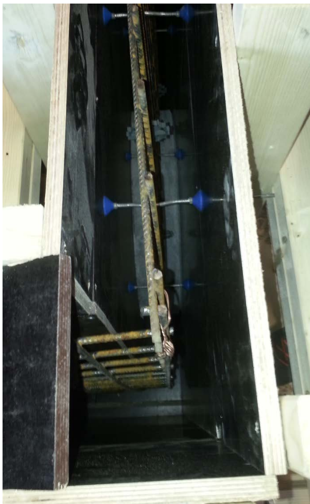
Bilde 13 Ser her fra toppen og ned i frontveggen, hvor det er lagt inn en utsparing for stikkrennen sin innpå kobling.
