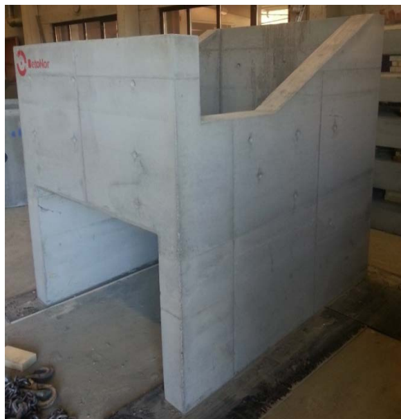
Bilde 14 Her er inntaksløsningen ferdig støpt og forskalingen er revet. Bildet viser baksiden, hvor det ble forskalet en innvendig kasse for å spare betong og vekt.
