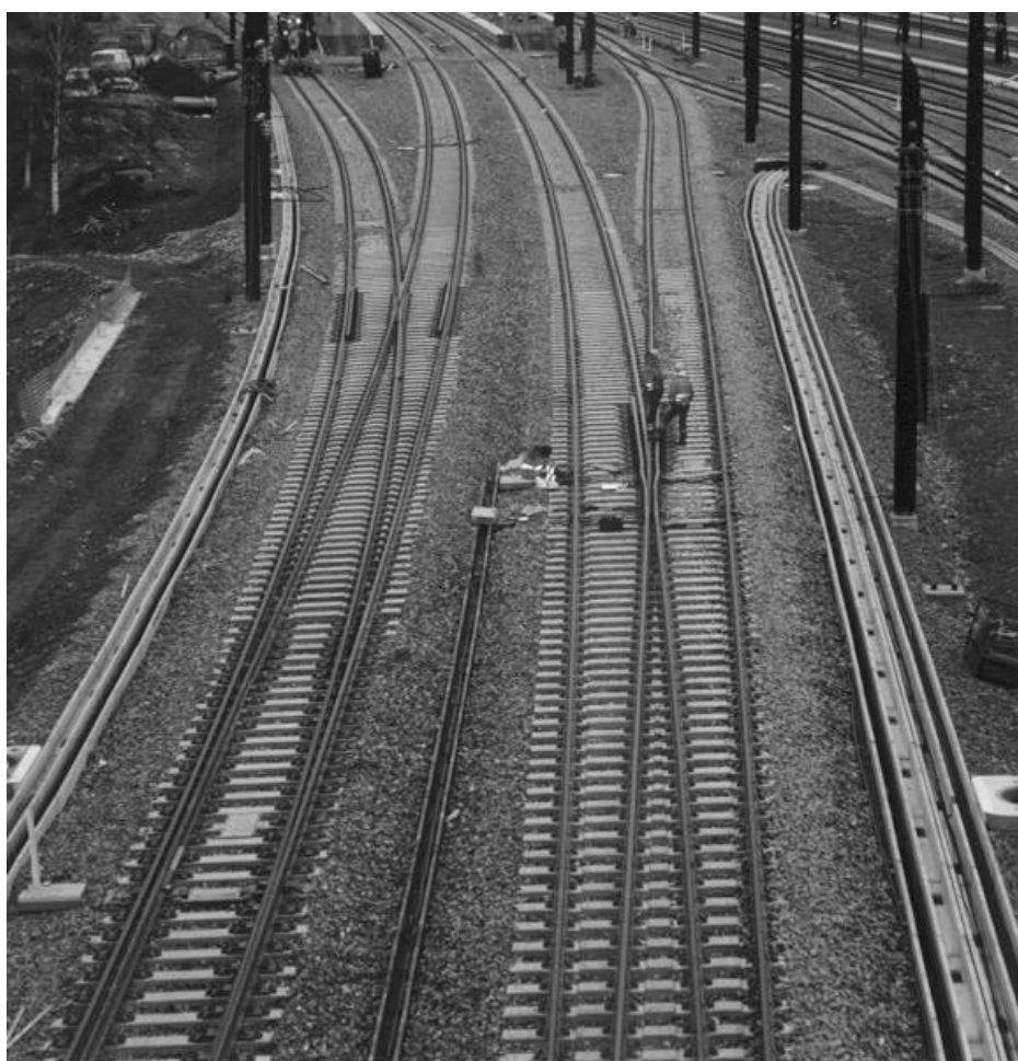
Figur 13 – Klotoidesporveksler på Gardermobanen ved Lillestrøm stasjon 25
