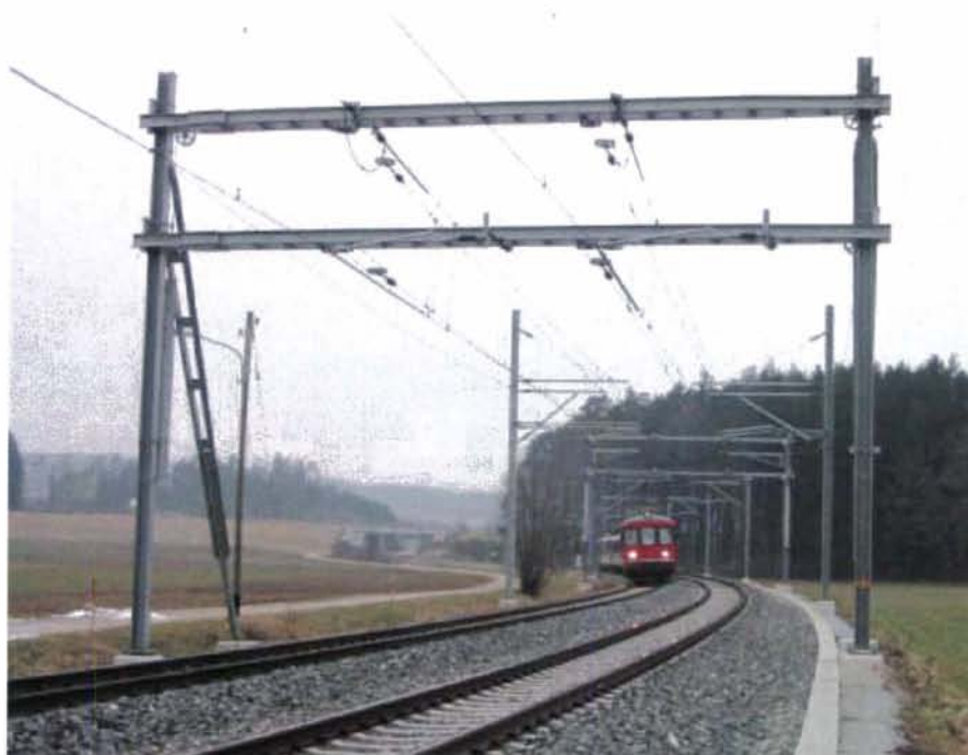
SBB - Kjøreledning; avspenningsmaster
