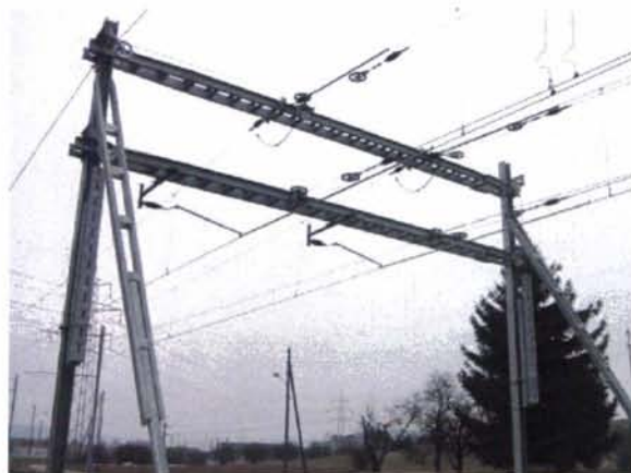
SBB - Kjøreledning; avspenningsmaster
