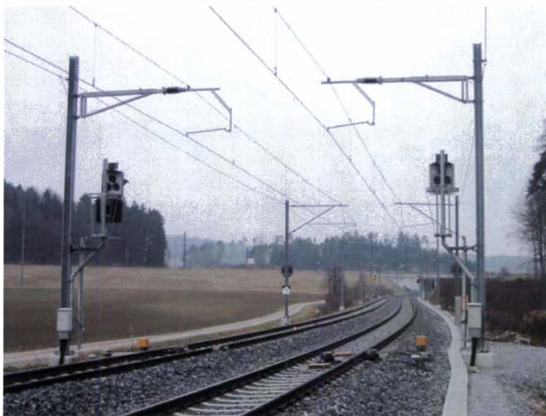
Kjøreledning SBB Typ R-FL 125 med utlegger NT
