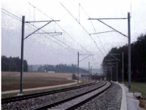
Kjøreledning SBB Type R
