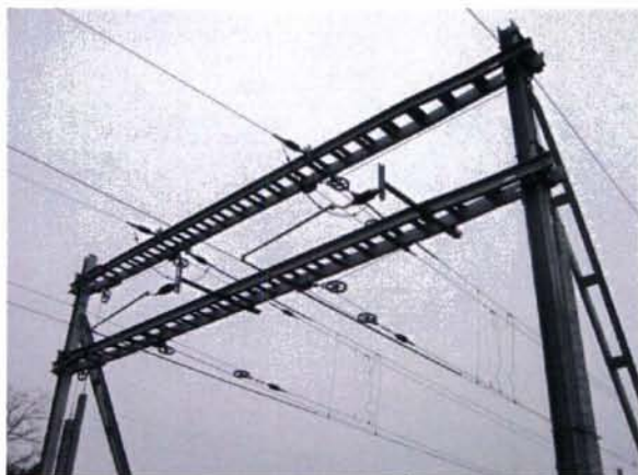
SBB - Kjøreledning; avspenningsmaster
