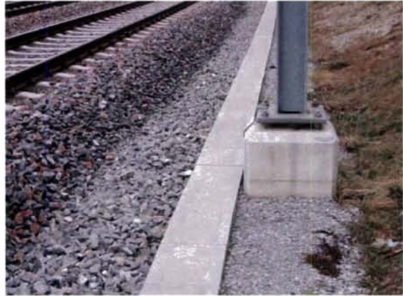
Mastfundamenter med skinnejording
