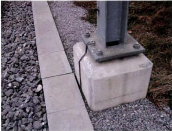
Mastfundamenter med skinnejording
