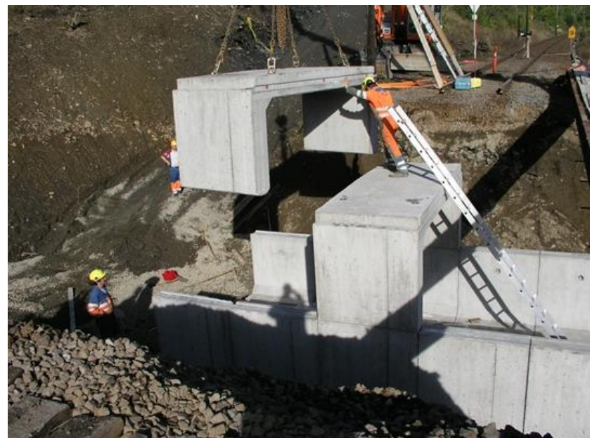
Innlegging av kulvert t.h. (Foto: Jernbaneverket)
