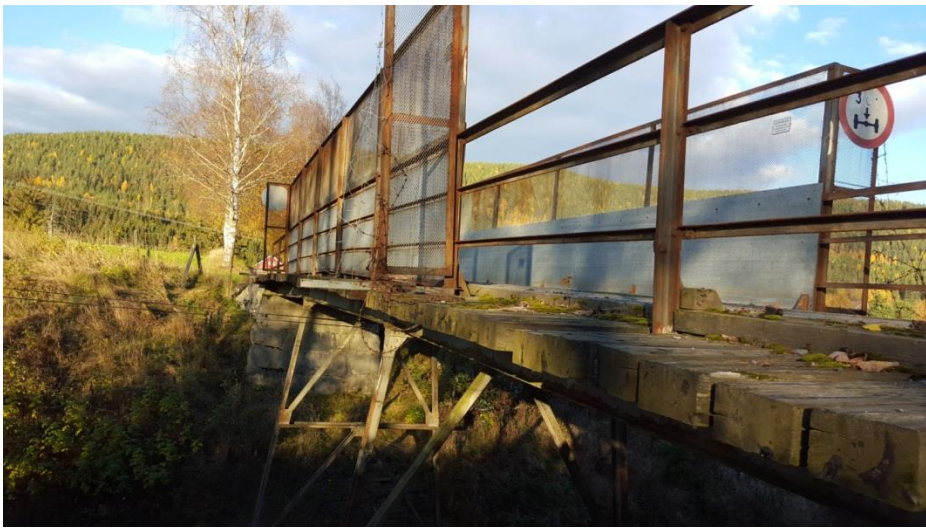
Bru før tiltak
