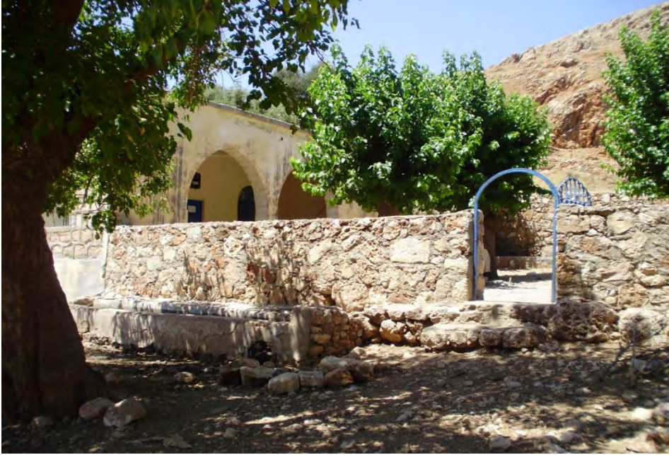
Foto 202: İlçenin En Eski Camilerinden Biri Olan Köklüce Köyü Camii, Yıkılan Bölümü Onarılarak Hizmet Vermeye Devam Etmektedir.
