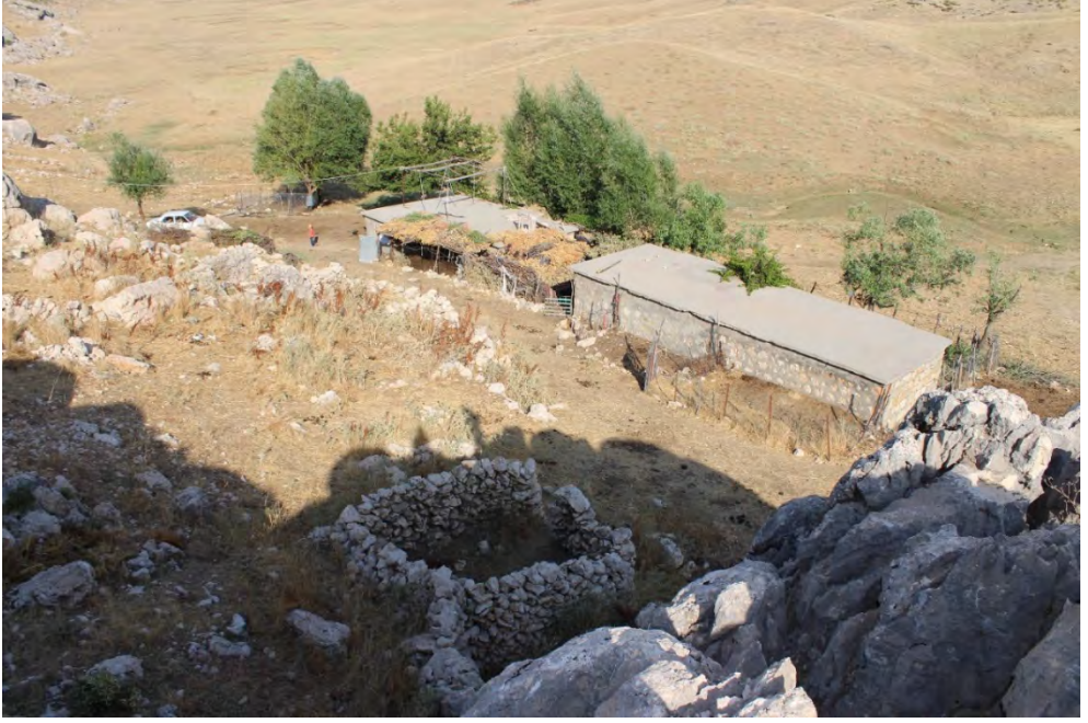
Foto 176: Avacık Yaylasında Betonarme Çatı Örtüsü
