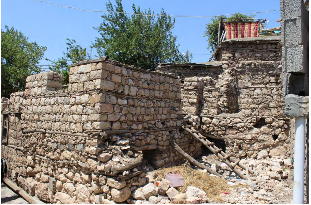
Foto 103: Taş Duvarların Arasına Yatay Olarak Döşenmiş Ahşap Direkler (Yeşilyurt Köyü)
