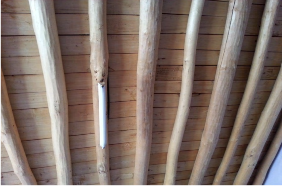
Foto 104: Ahşap Çatı Örtü İskeleti (Yeşilyurt Köyü)
