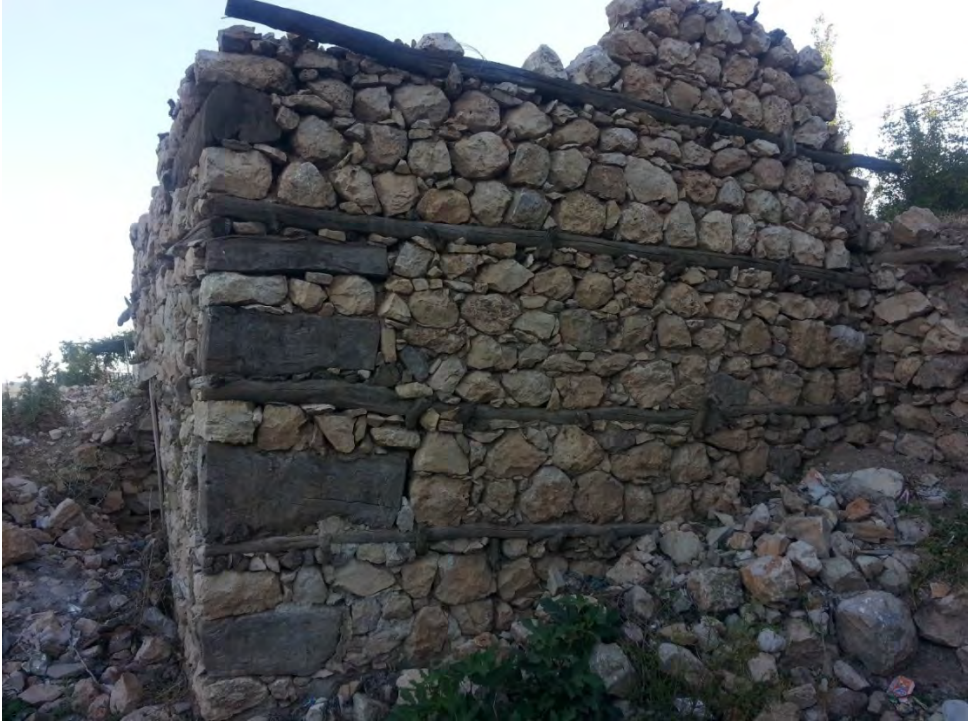
Foto 101: Herhangi Bir Bağlayıcı (Çimento) Malzeme Kullanılmadan Taş malzemeyle İnşa Edilen Bir Mesken (Gürgenli Köyü)
