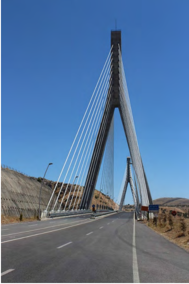
Foto 191: Nissibi Köprü Gergin Eğik Askılı Köprü Tazında İnşa Edilmiştir (2016)
