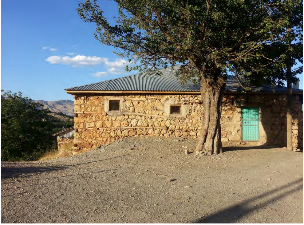
Foto 110: Çatı Örtü Malzemesi Olarak Sac Kullanılması (Gürgenli Köyü)
