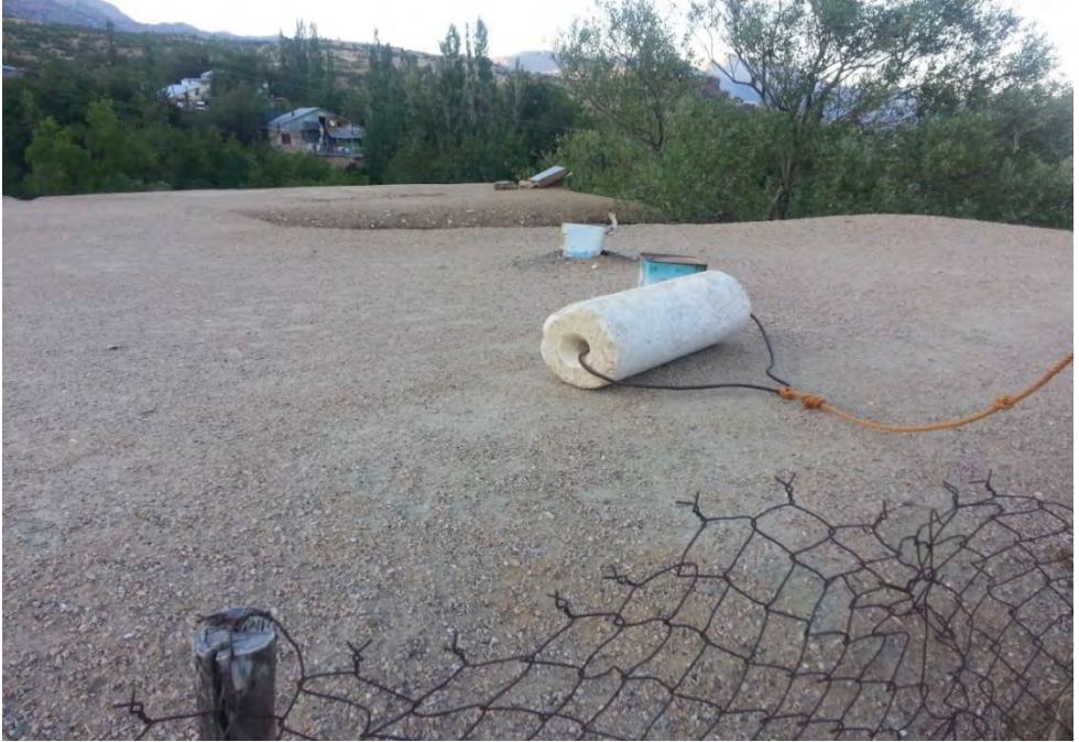
Foto 109: Toprak Çatı Örtüsünün Sıkılaştırılması Amacıyla Kullanılan ve Loğ Adı Verilen Mermer Silindir.
