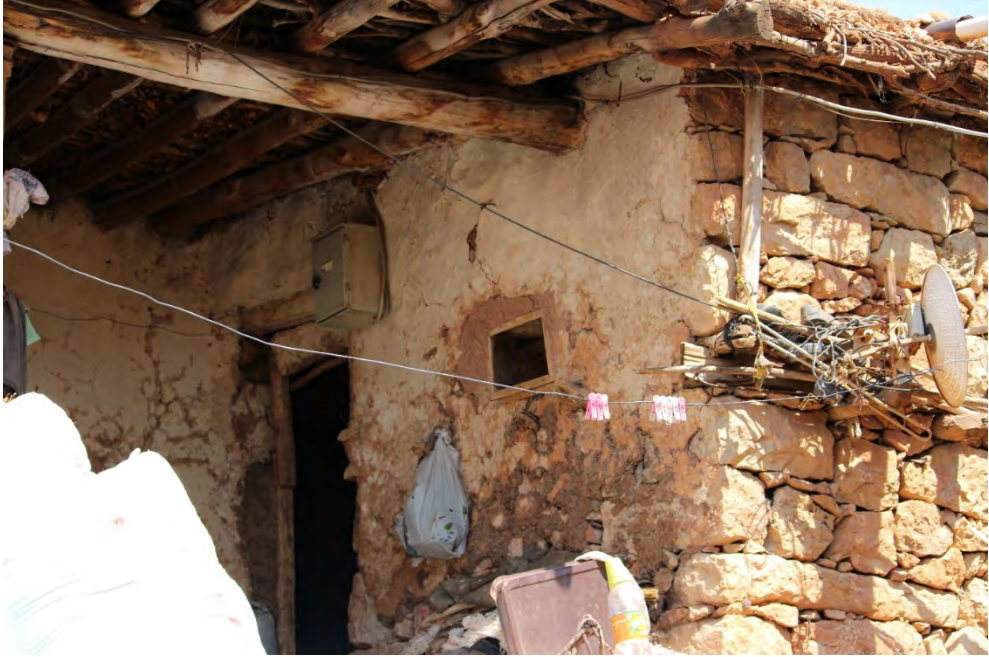
Foto 107: Taş, Toprak ve Ahşap Malzemenin Birlikte Kullanıldığı Bir Köy Meskeni (Eskikent Köyü)
