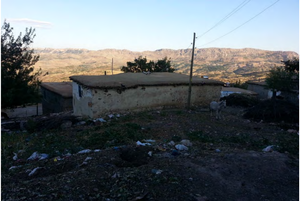
Foto 106: Kerpiç Mesken (Gürgenli Köyü)
