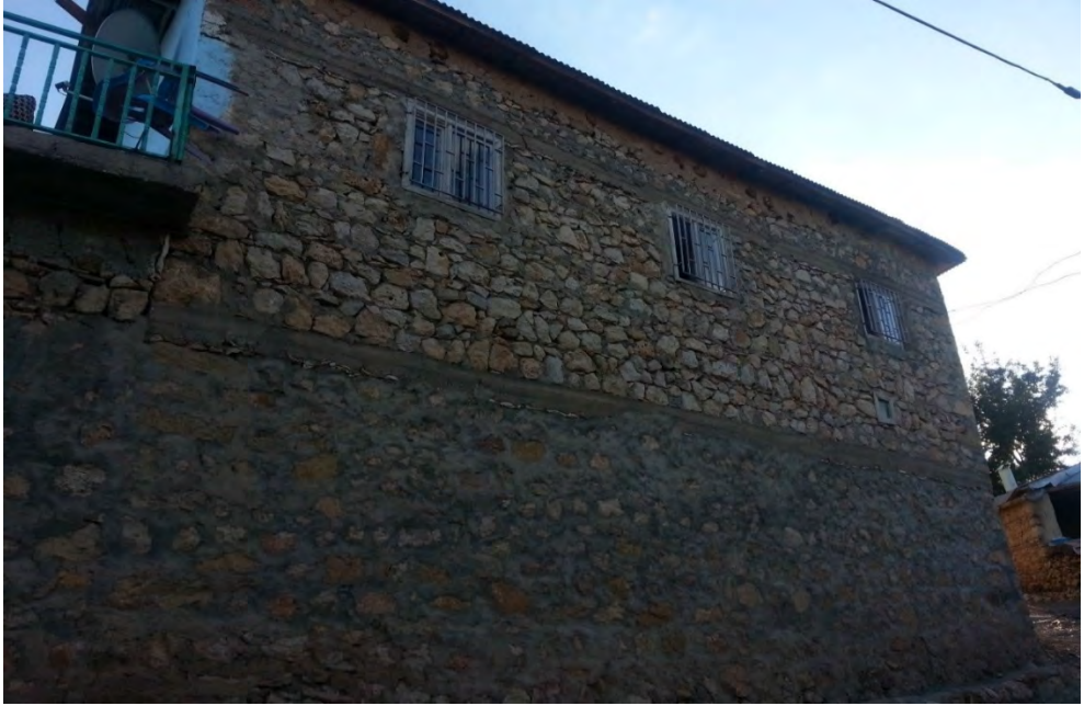
Foto 105: Taş Meskenlerde Çimentonun Bağlayıcı Malzeme Olarak Kullanılması (Gürgenli Köyü)
