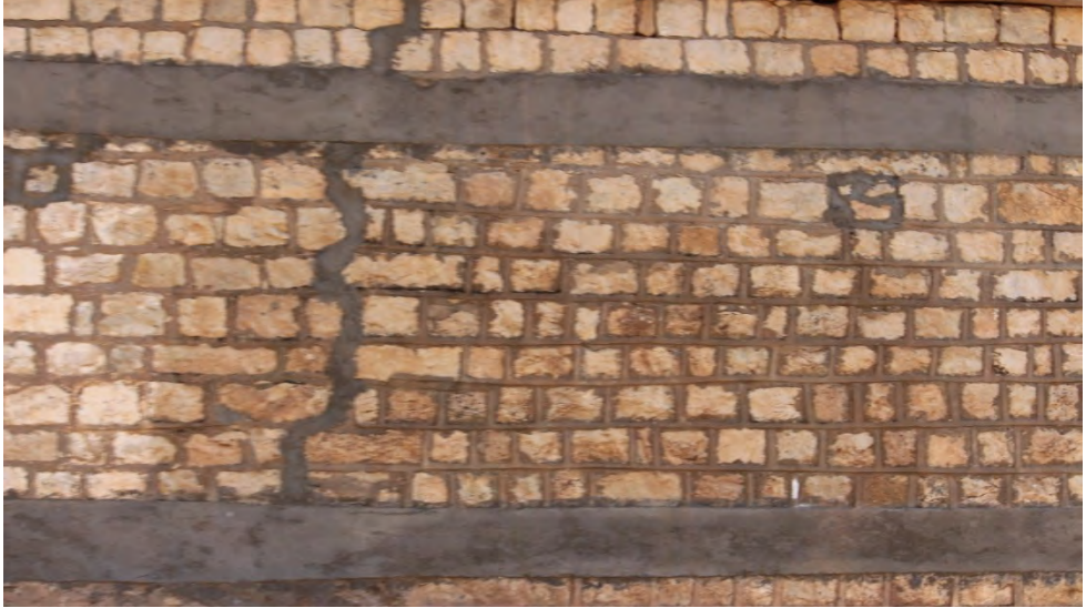
Foto 100: Taş Malzemeye Kısmen Şekil Verilerek İnşa Edilmiş Bir Mesken (Eskikent Köyü)
