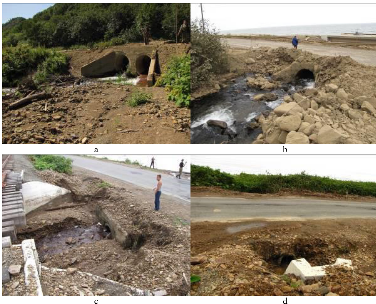
Рисунок 4. Водопропускные трубы на селеносных ручьях: восточное побережье Южного Сахалина, Макаровский район (а и b), и западное побережье Южного Сахалина, Невельский район (с и d) Figure 4. Culverts on the debris flow rivers of Sakhalin Island: the Eastern coast of Southern Sakhalin, Makarov district (a and b), and the Western coast of Southern Sakhalin, Nevelsky district (c and d)
