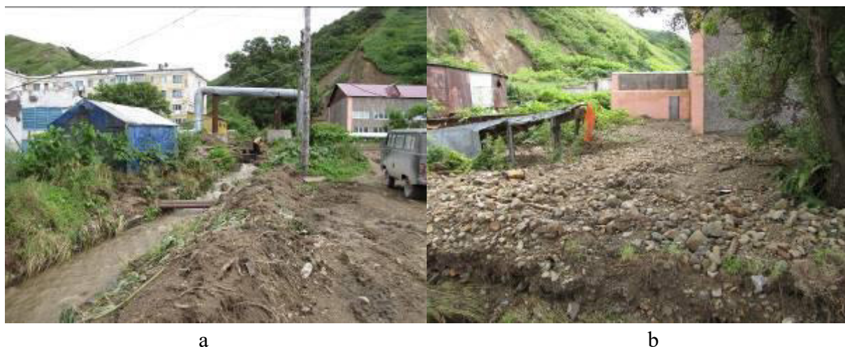
Рисунок 2. Селевой ручей в городе Невельск (2010 г.): зарегулированное русло ручья после схода селя (a) и селевые отложения за пределами бетонного лотка (b)
