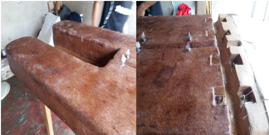
Figura 52. Primera capa de fibra de vidrio aplicada completamente.
