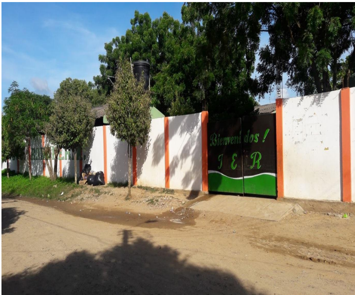
Foto N°1. Entrada principal de la Institución Educativa Ranchería
