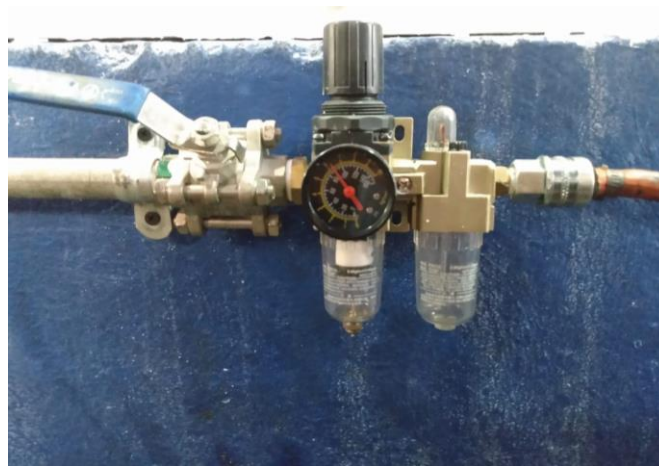
Figura 23. Unidad de mantenimiento. Fuente (Registro fotográfico, 2019)
