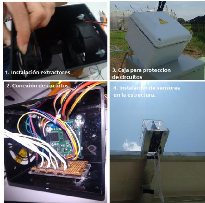
Figura 65. Instalación de los circuitos electrónicos. Fuente: elaboración propia.
