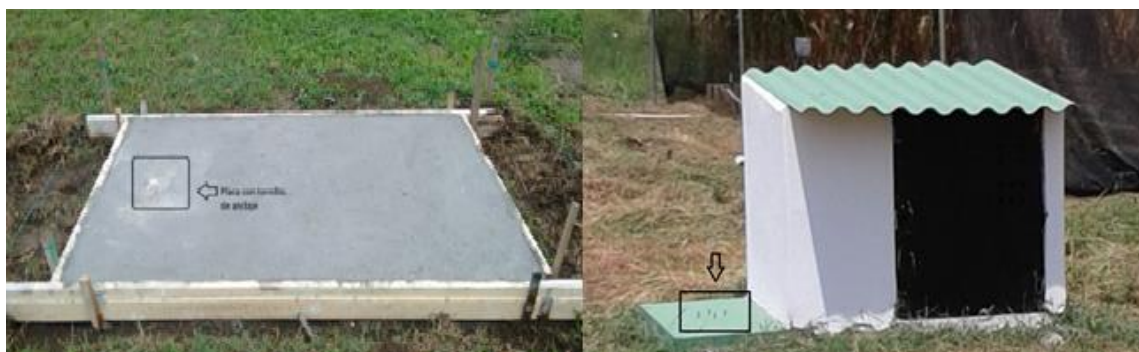
Figura 62. Zapata en concreto y bodega para la protección de los componentes. Fuente: Elaboración propia.
