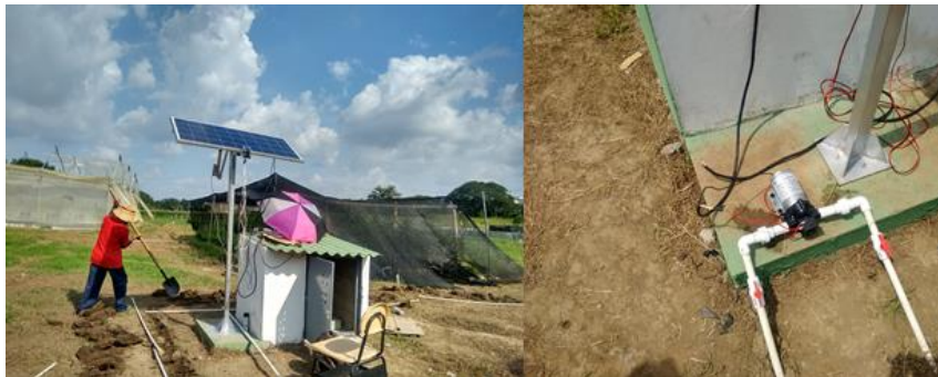
Figura 63. Instalación circuito de agua Fuente: Elaboración propia.
