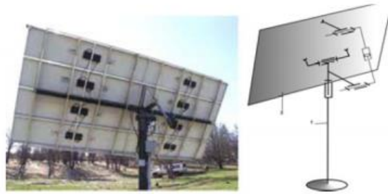
Figura 18. Seguidor solar activo
