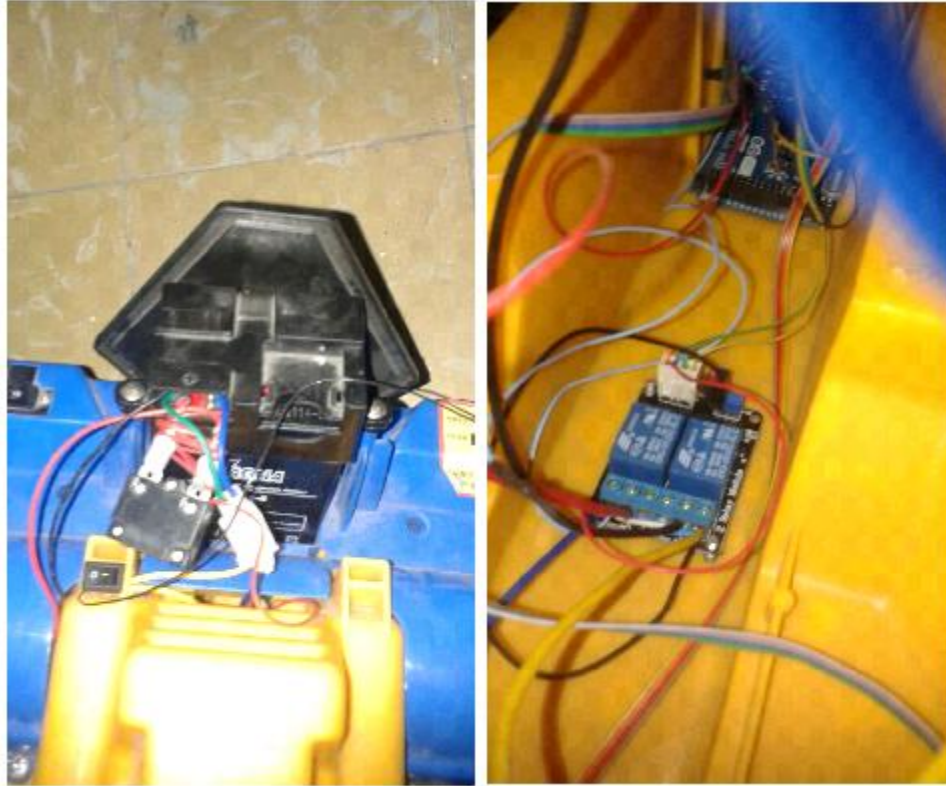
Figura 43. Fuente de carga y modulo relé
