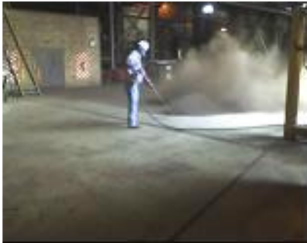
Figura 9. Trabajador limpiando el piso de carga con aire comprimido
