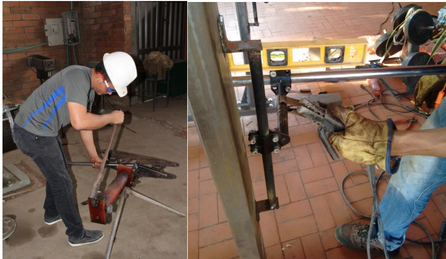
Figura 49. Proceso de doblado y soldadura en los pasamanos.
