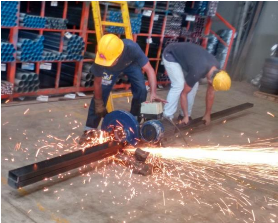
Figura 42. Proceso de corte en la viga superior.
