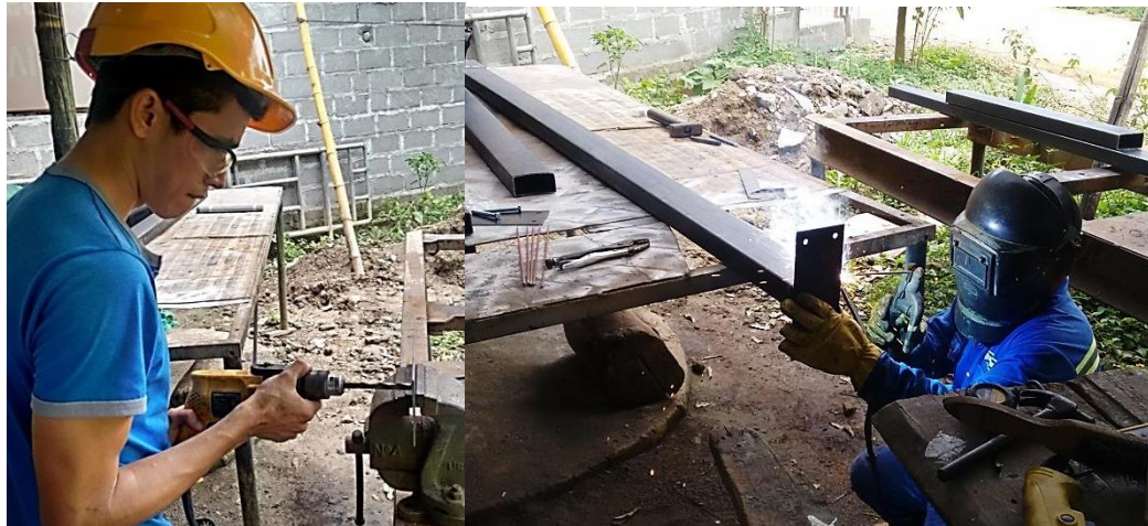
Figura 44. Proceso de taladrado y soldadura en las columnas.
