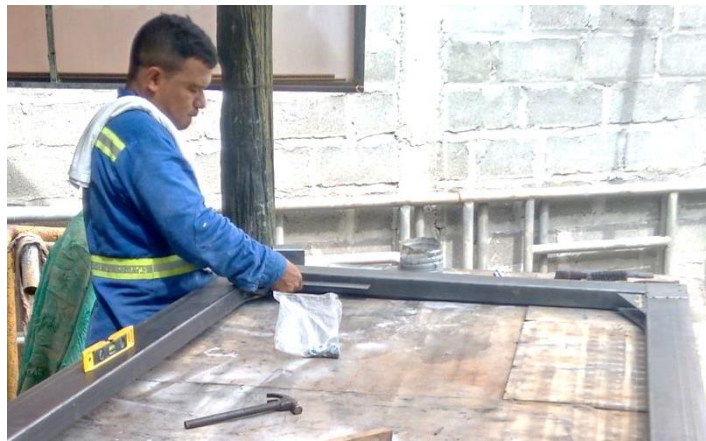
Figura 52. Ensamble de las columnas con la viga superior.
