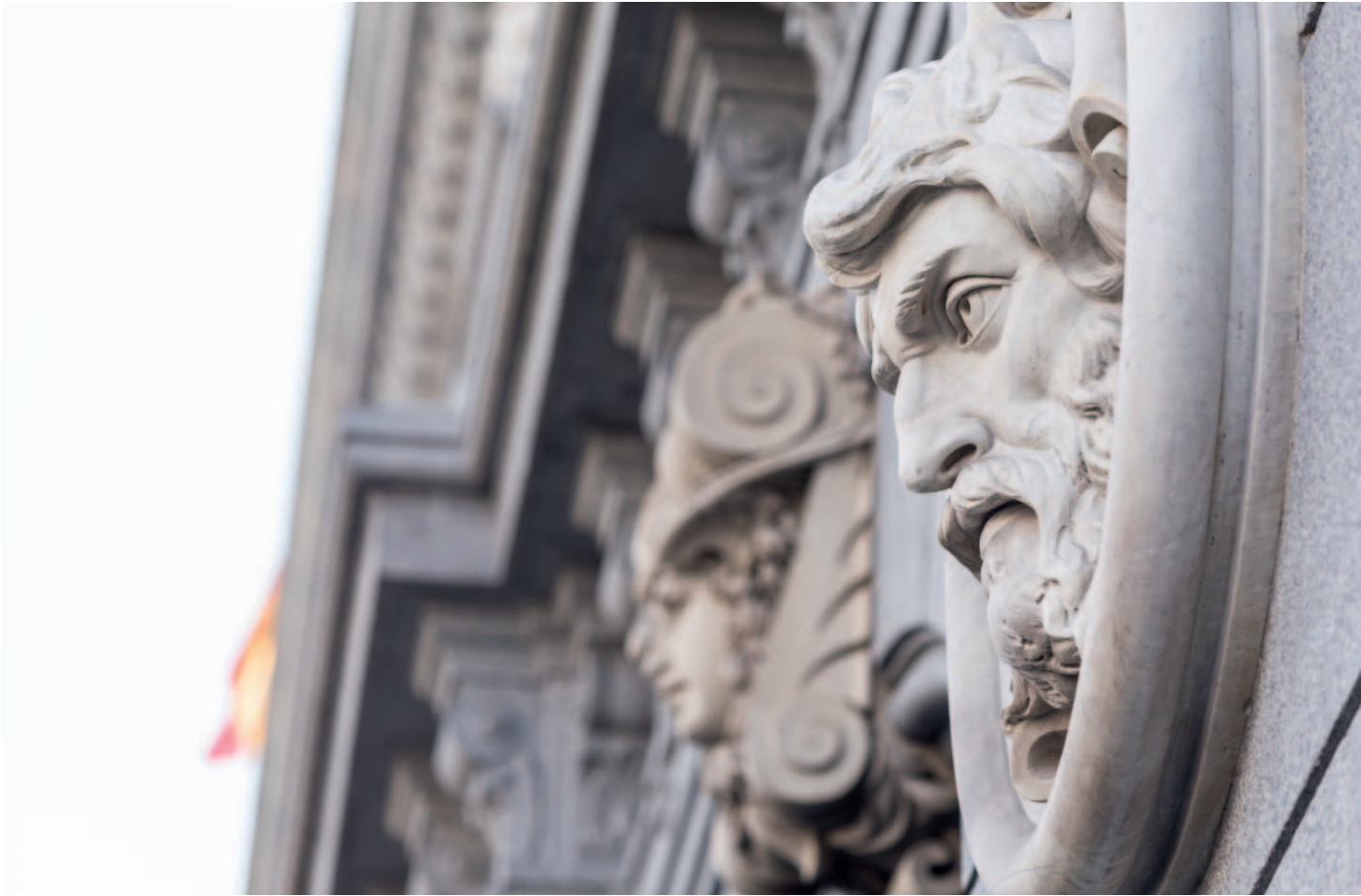
Medallón labrado en piedra caliza del parámetro de la fachada del edificio de Cibeles.
