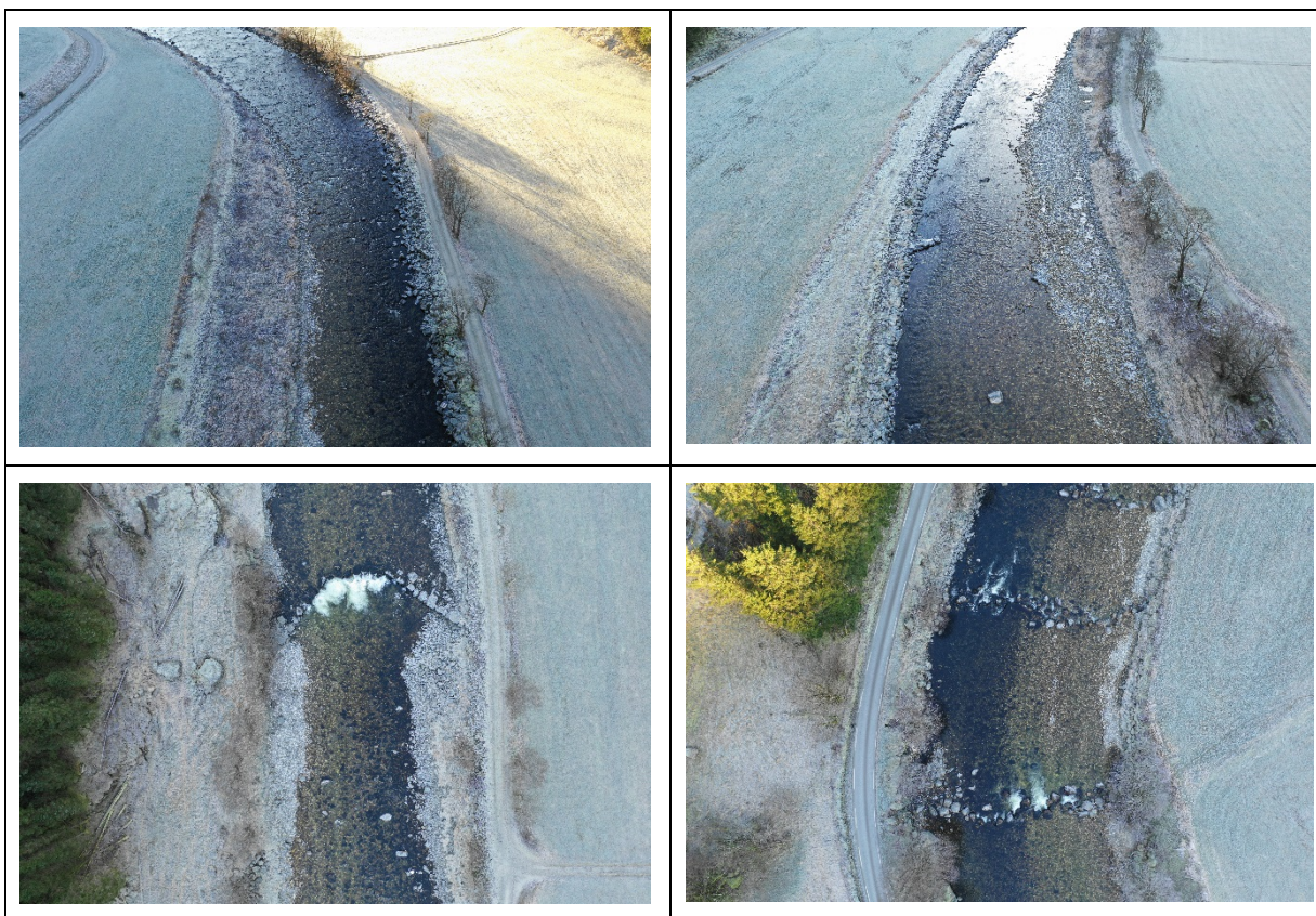
Øverst: Steinsetting og buner. Nederst: Terskel uten lavvannsrenne og delvis oppløste terskler.
