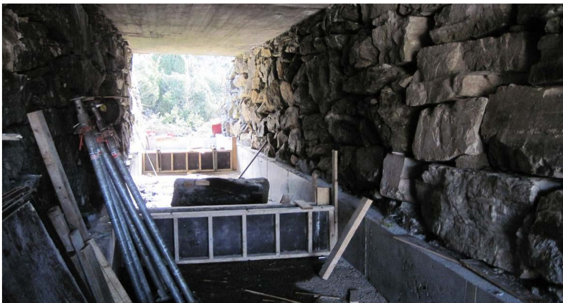
Figur 5. Bildet fra bygging av ny veikulvert ved en bekk i Sotra, Hordaland våren 2010. Her støpes det tverrvegger for å lette oppvandringen for fisk.
