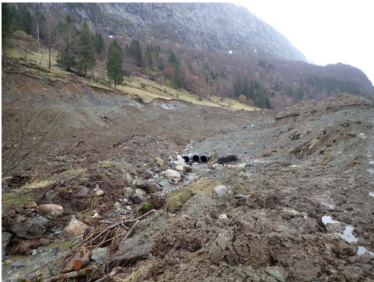
Figur 58. Tilløpsbekken til Rivedalselva var nylig lagt i rør under kartleggingen.
