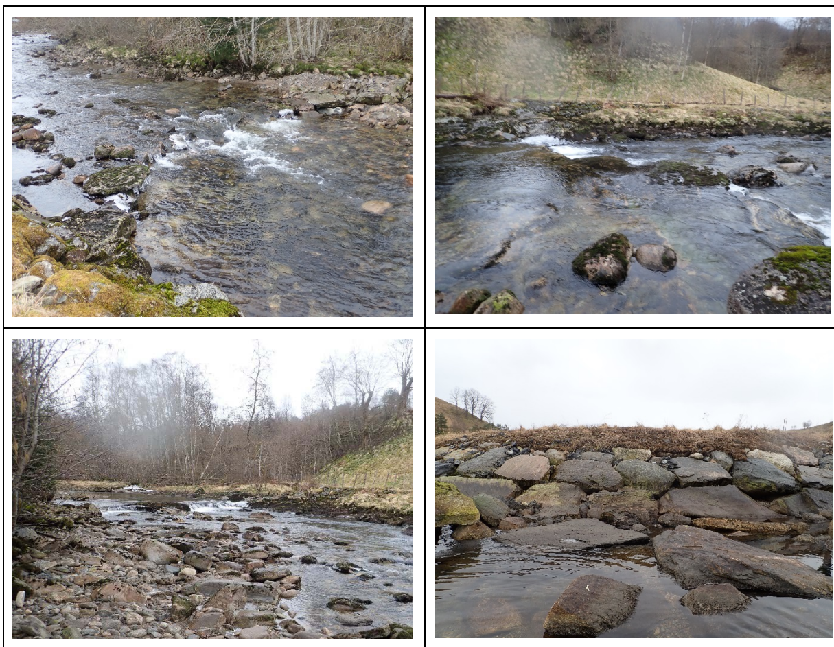
Øverst: Terskler i øvre del av Ryggelva. Nederst: Terskel og erosjonssikring i form av glatt plastring langs elvebredden ved tersklene.
