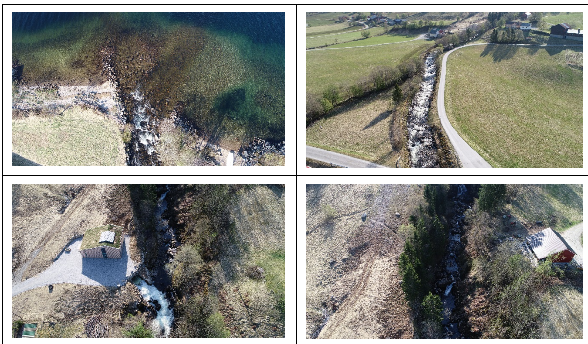
Elvemunningen til Jølstravatnet (øverst til venstre) kulp-stryk parti og fjernet kantvegetasjon (øverst til høyre). Kraftutløp av Myklebost kraftverk (nede til venstre). Juv og vandringshinder (nede til høyre).
