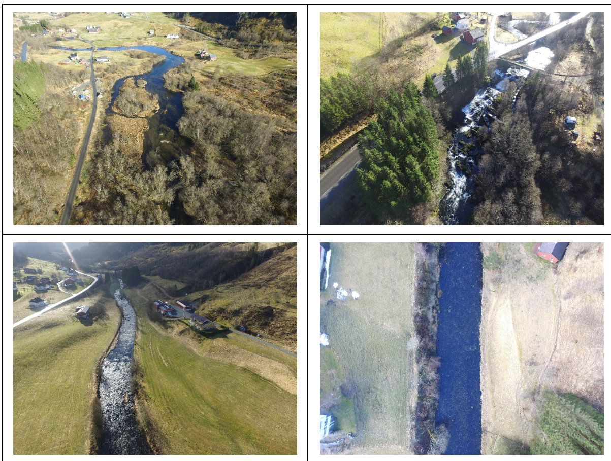
Store gyteplasser nedstrøms av kraftutløpet (øverst til venstre), foss med fisketrapp (øverst til høyre), fjernet kantvegetasjon (nede til venstre), kanalisering og mosegrodd substrat (nede til høyre).
