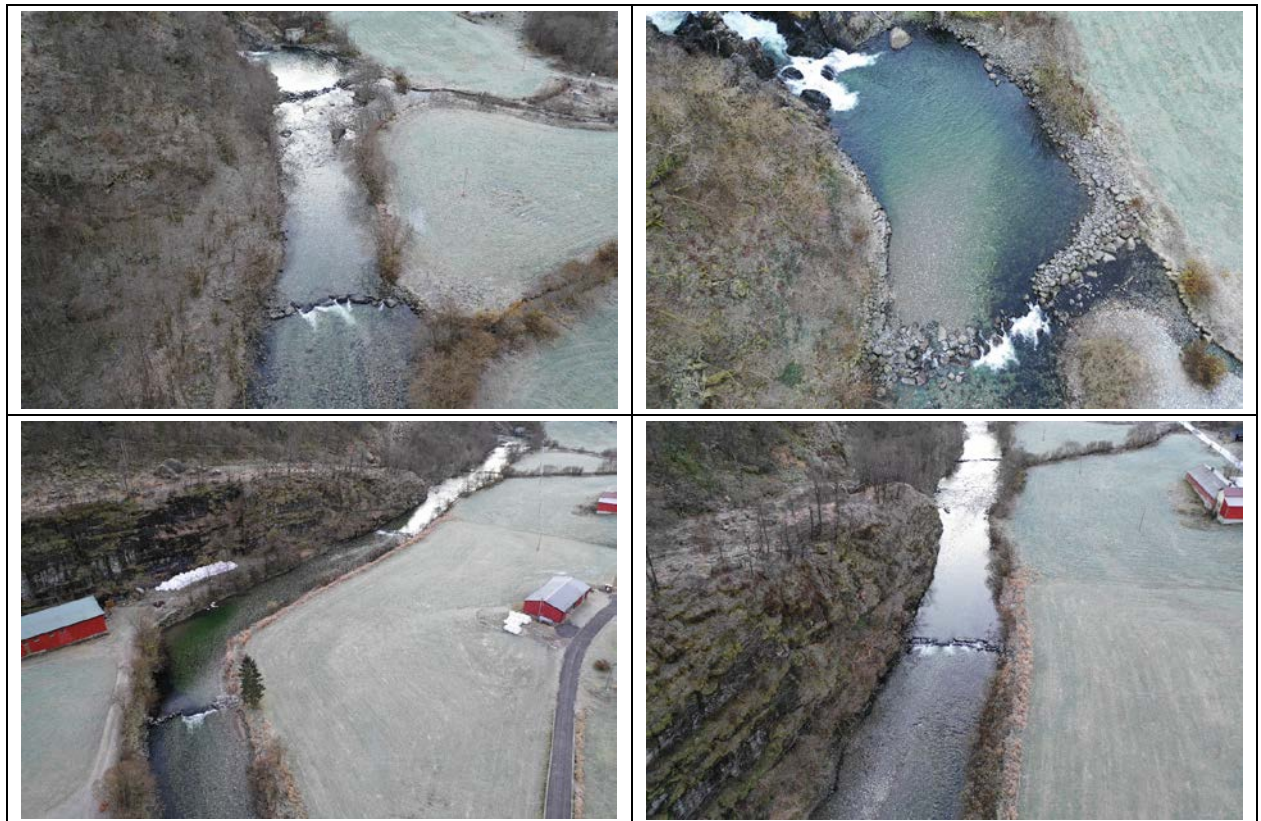
Dronebilder av noen av tersklene i øvre del av Hopselva.
