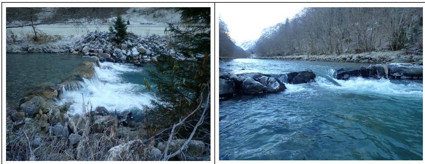
Terskler preger Supphelleelvi til en viss grad. Noen av tersklene hadde en lavvannsrenne og fungerte tilfredsstillende (høyre bilde) mens andre var delvis vandringshinder for laksefisk (venstre bilde).
