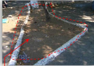
Área erosionada y extinción de césped por la falta de mantenimiento
