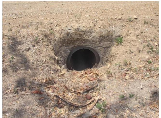
Alcantarilla totalmente socavada en el tramo que va del empalme container a los Cocos
