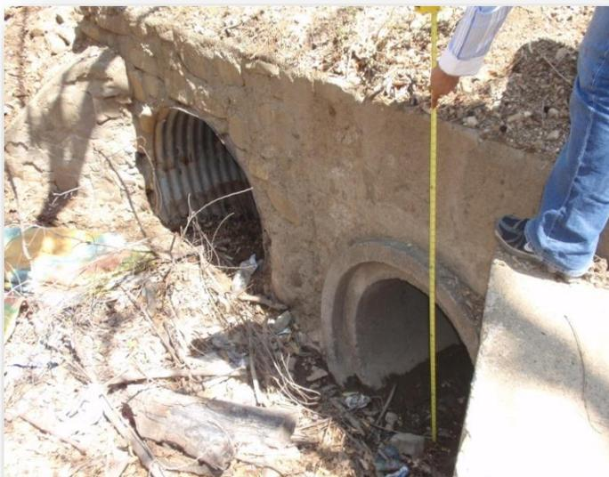
Alcantarilla mixta con tubería metálica y de concreto con diámetros de 30 y 42 pulgadas, en regular estado y con aparente insuficiencia hidráulica.
