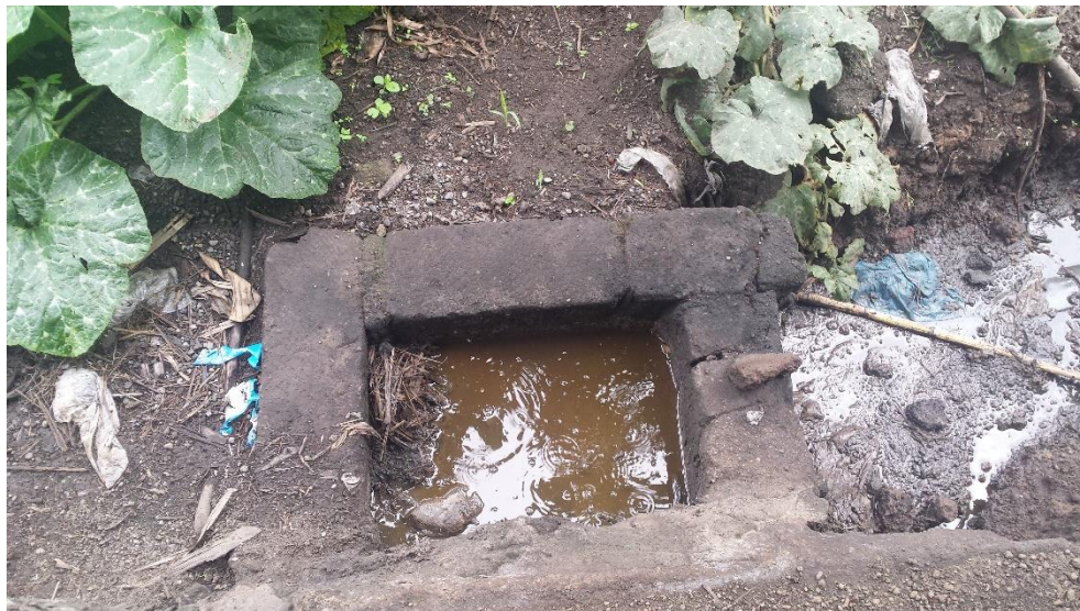
Foto 17. Caja de registro del desalojo de aguas residuales del trapiche
