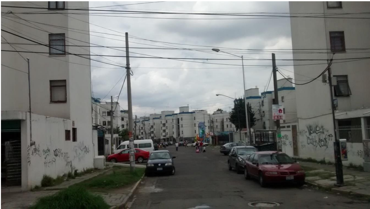
Fotografía 14 Infraestructura aérea saturada.
