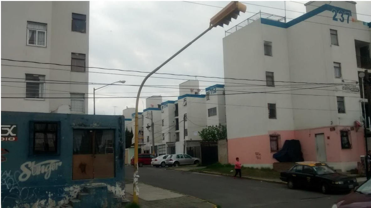
Fotografía Complementaria 28 Ausencia de paraderos o cubiertas que resguarden a los habitantes durante la espera de su transporte público.
