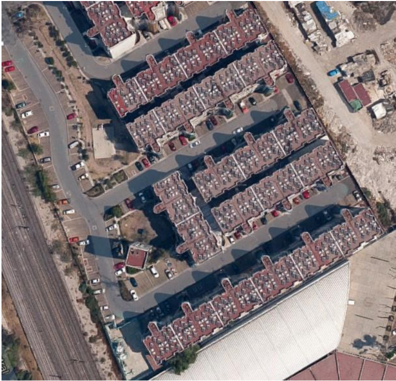
Figura 8 Acercamiento vista superior del conjunto habitacional.
