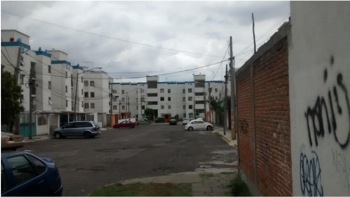
Fotografía 15 Pavimentos y banquetas en mal estado.
