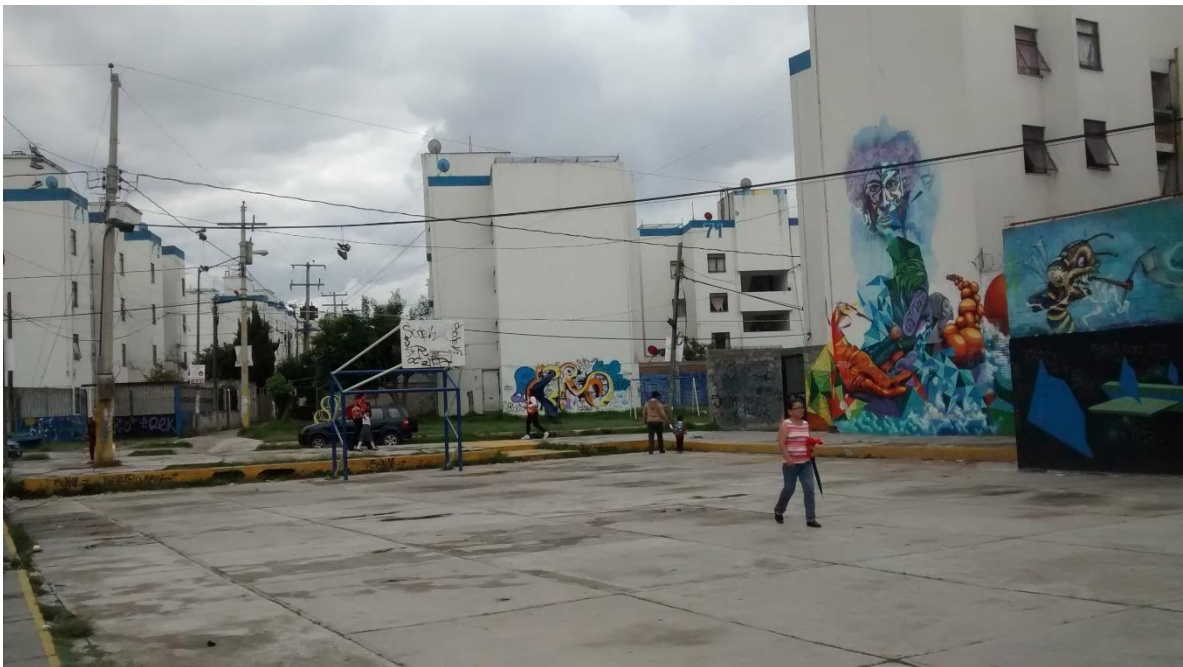
Fotografía 10 Una de dos canchas para las actividades deportivas de los habitantes. Tablero de basquetbol disfuncional y superficie áspera de la cancha inapropiada para desempeñar a plenitud la actividad.
