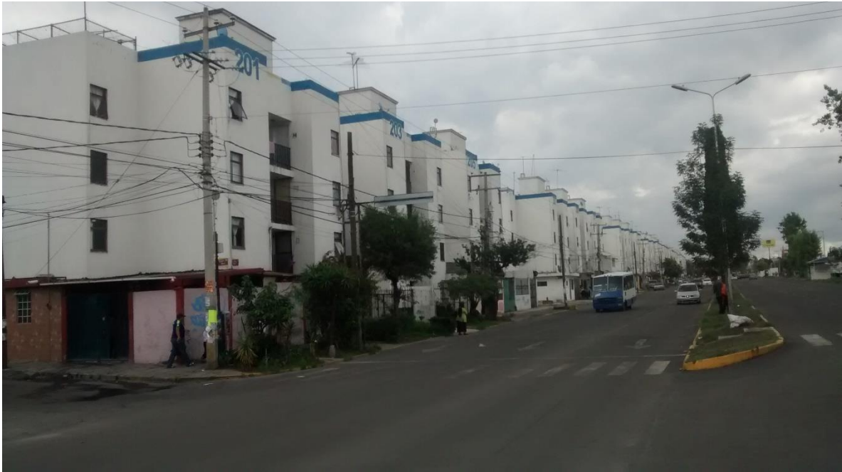
Fotografía 9 Vista sobre el Blvd. Xonacatepec.
