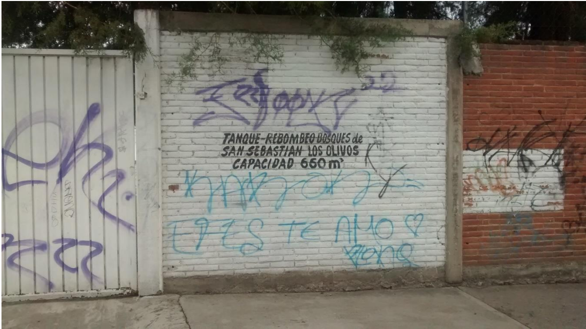
Fotografía Complementaria 23 Acceso al tanque de rebombeo.
