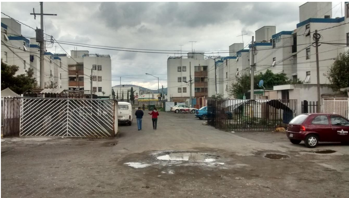
Fotografía 4 Pavimentos deteriorados y con baches.
