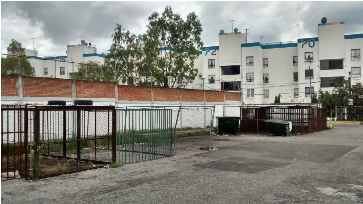
Fotografía Complementaria 10 Protecciones de vehículos provisionales.
