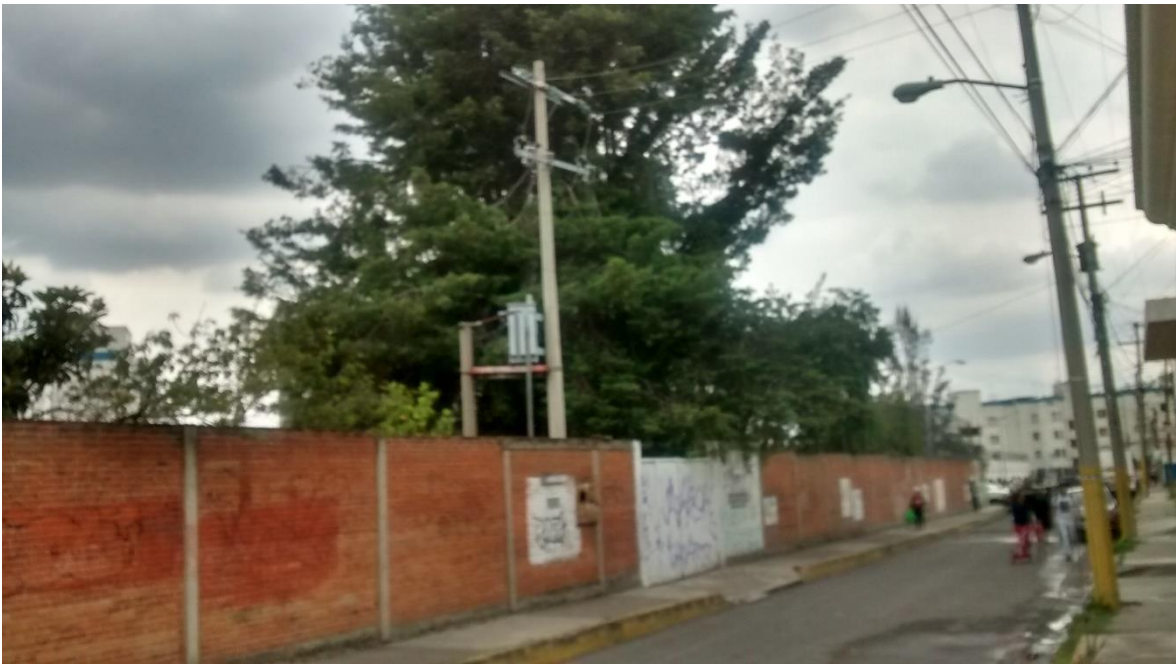
Fotografía 24 Acceso al tanque de rebombeo.
