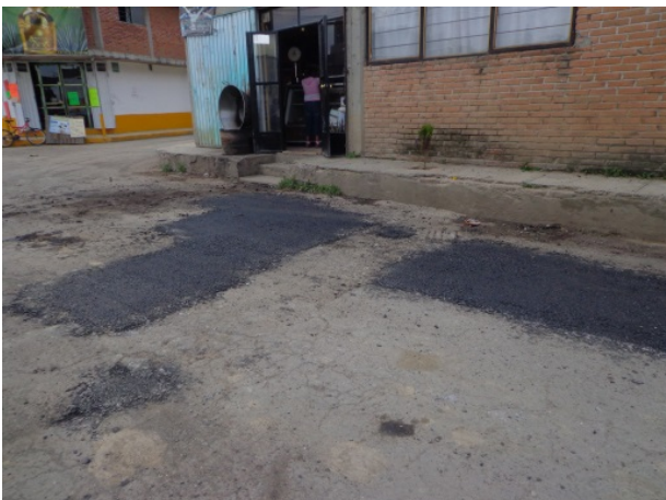
Figura 57. Repavimentación de calles Autor: Anónimo Año: 2015
