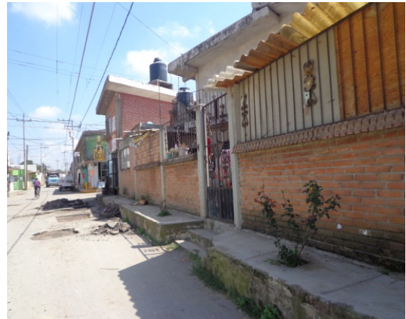
Figura 65. Infraestructura en malas condiciones Autor: Anónimo Año: 2015
