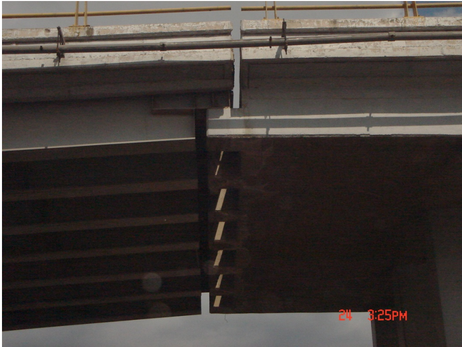
Figura No. 6. Vista lateral de junta en puente de acero
