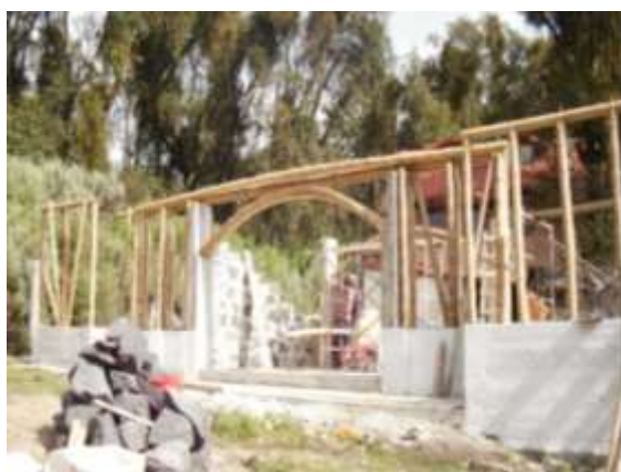
Figura 3.12 Armado de arcos
