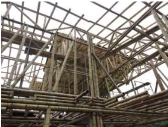
Figura 3.18 Colocación de triplay en cubierta
