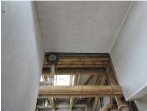
Figura 2.44 Zona de regadera
