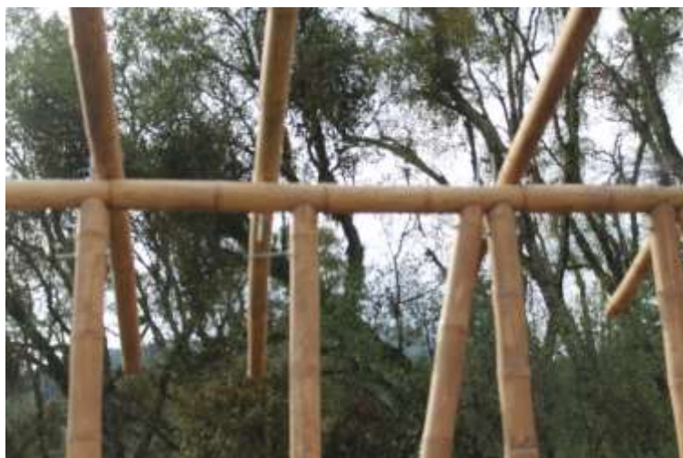
Figura 2.31 Viga de Guadua
