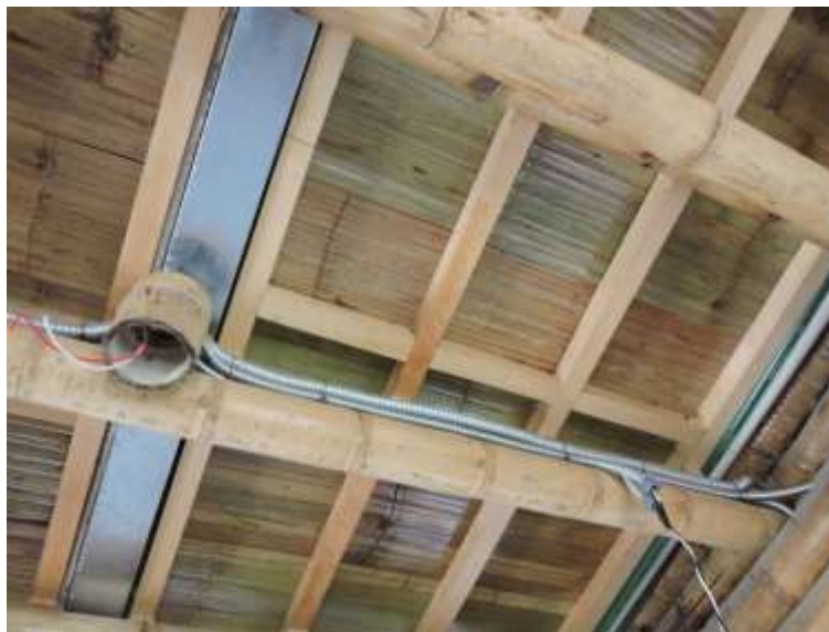
Figura 3.27 Colocación de tubería sapa
