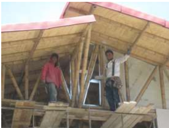
Figura 3.23 colocación de muro de durock
