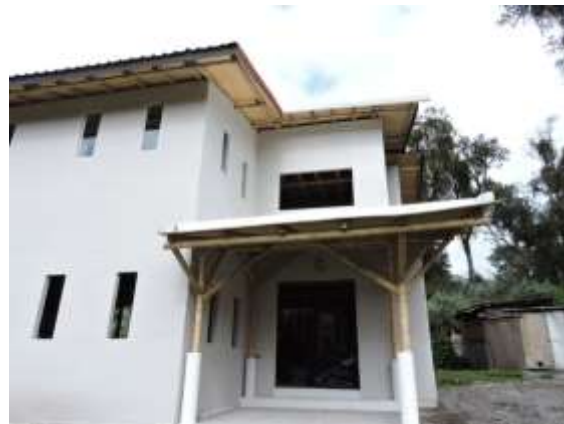
Figura 2.14 Aplicación de Cempanel
