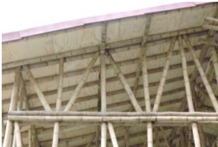
Figura 2.36 Armadura de elementos de Guadua
