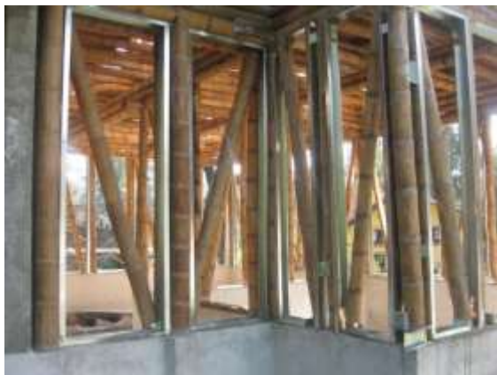
Figura 3.20 Colocación de postes
