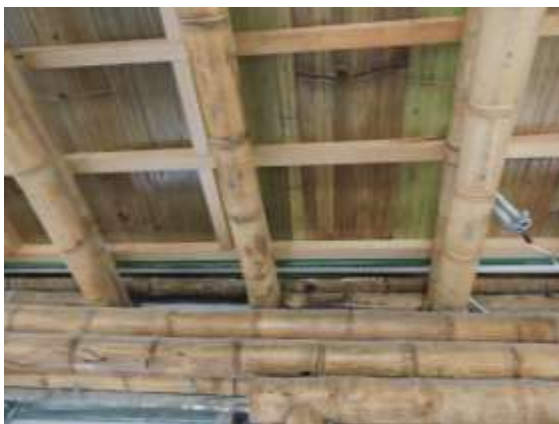
Figura 2.16 Plafón de planta baja
