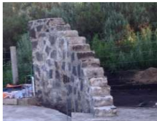
Figura 3.7 Muro de piedra braza
