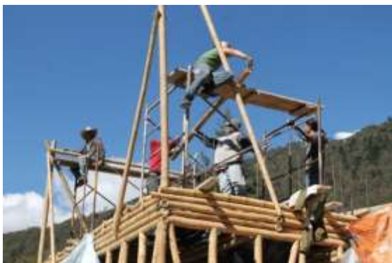
Figura 3.16 colocación de columnas en esquinas
