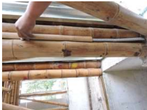
Figura 2.41 Recubrimiento de tubería
