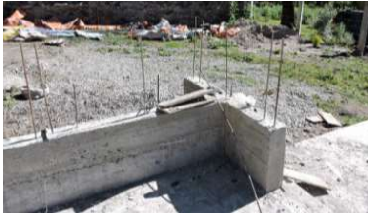
Figura 2.20 Varillas de anclaje en sobre cimiento
