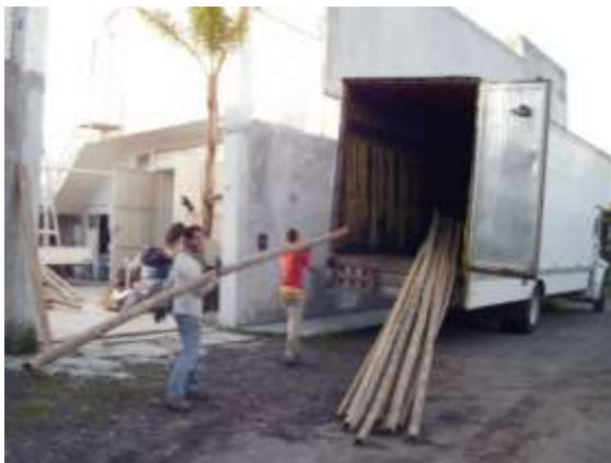
Figura 3.10 Descarga de material
