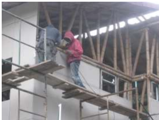
Figura 3.21 Colocación de Cempanel
