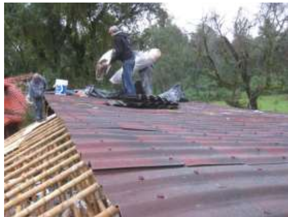
Figura 3.19 Colocación de lamina
