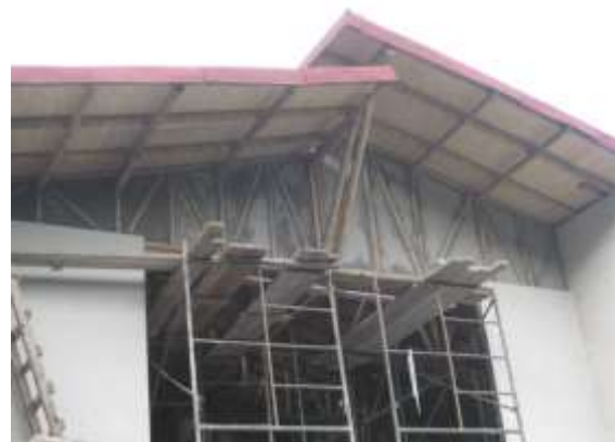
Figura 3.24 Muro de durock en fachada
