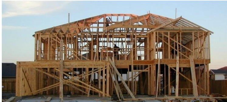
Fig. 1.9. Estructura con método “Balloon framing” (Wikipedia, 2015).
