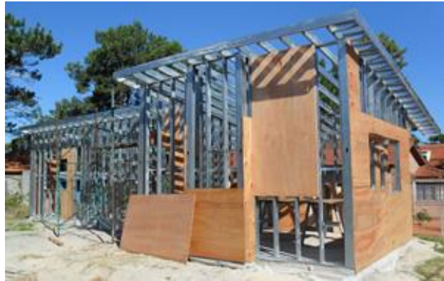
Fig. 1.10. Estructura con método “ Steel framing ” (STEELFRAMING.COM, 2012).
