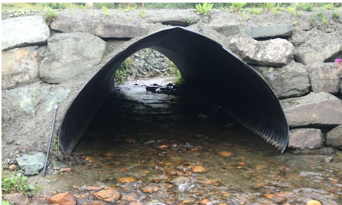
Bilde 6. Den nye kulverten i Loa under Lebergsveien er et forbilledlig eksempel på en god løsning på krysning av vei over vassdrag. Det anbefales at løsningen tas i bruk ved krysningen av Søvassveien over Søvassbekken. Foto: NINA.
