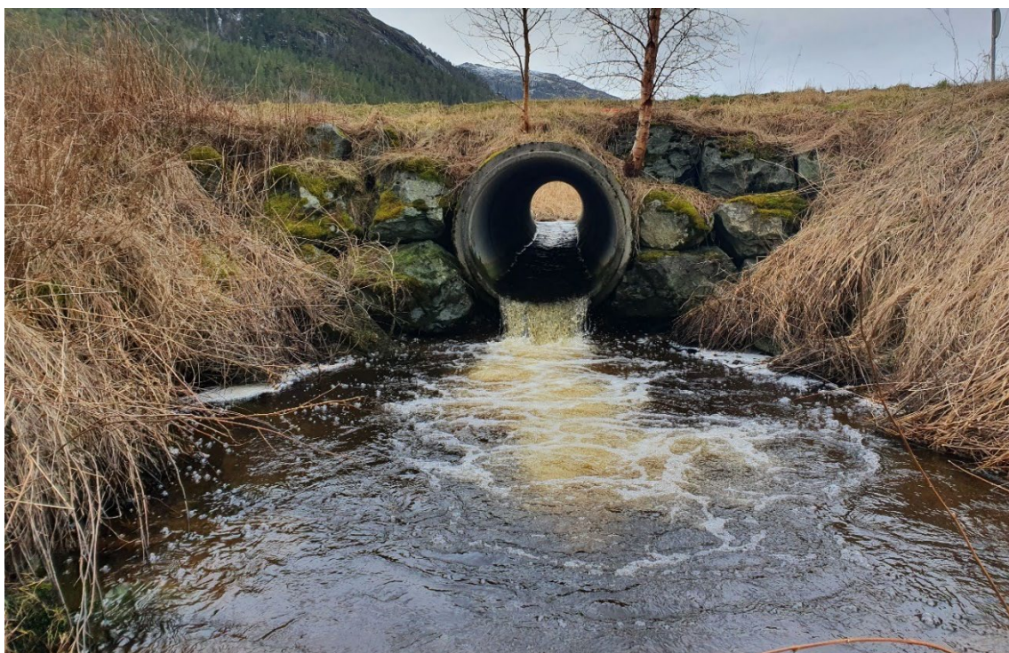
Bilde 4. Bekken går i kulvert under første veikryssing av Oldveien. Foto: Torgeir B. Havn, NINA.
