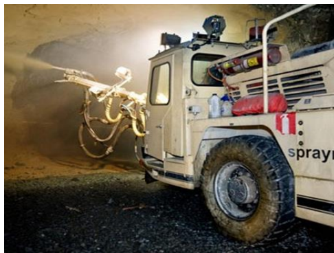
Figura 4 – Equipamento Spraymec na projeção de projeto Fonte: www.normet.com
