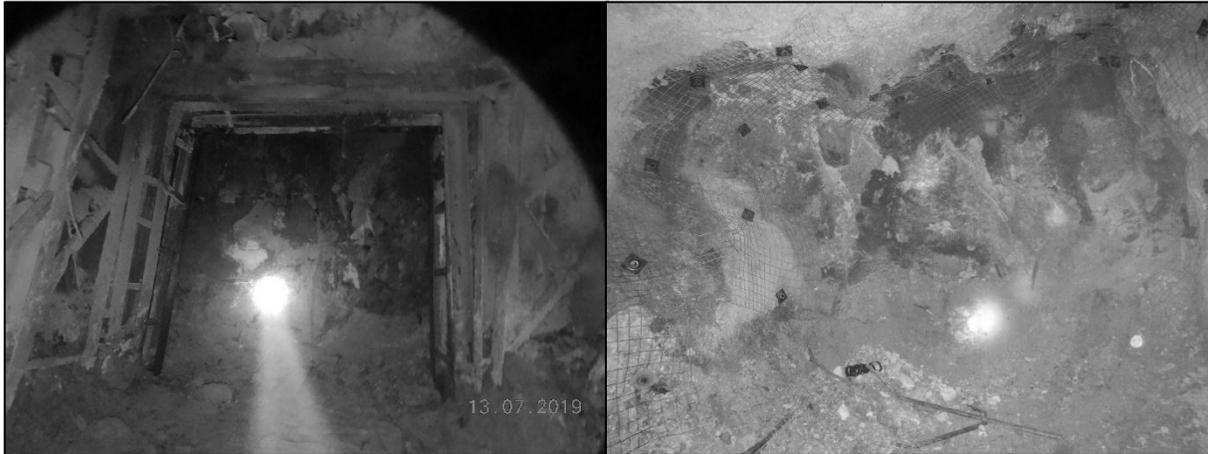
Gambar 8 (kiri). Kondisi *heading* XC 662.1 beberapa hari setelah berhasil dilakukan penembusan ambrukan; (kanan). Kondisi *heading* XC 662.1 saat ini menggunakan penyanggaan standar
