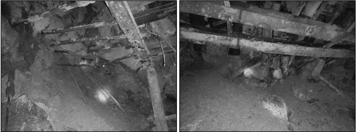
Gambar 7 (kiri). Pipa *spilling* yang di *grouting* dipasang dengan spasi 30-40 cm dapat menahan material ambrukan dari rongga; (kanan) Kayu stapling sebagai bantalan pipa *spilling* yang terkena ambrukan *boulder* besar
