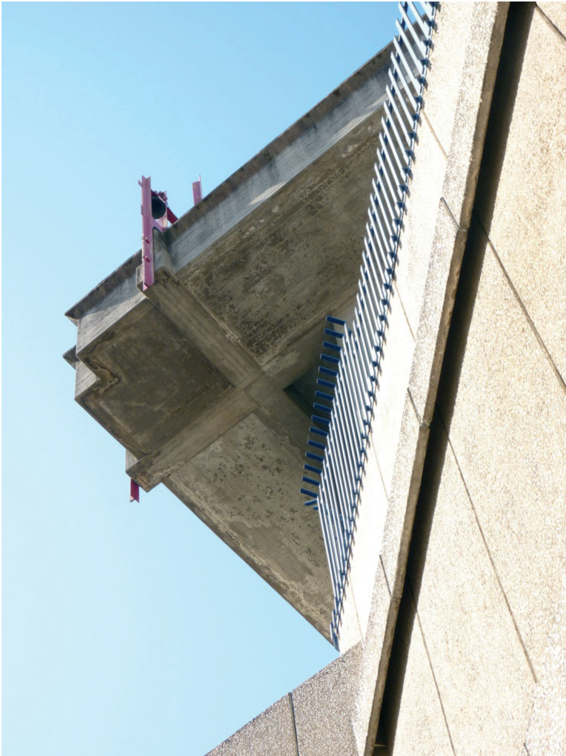
Ilustração 10 – Detalhe da cobertura exterior da Igreja do Sagrado Coração de Jesus (Ilustração do autor)
