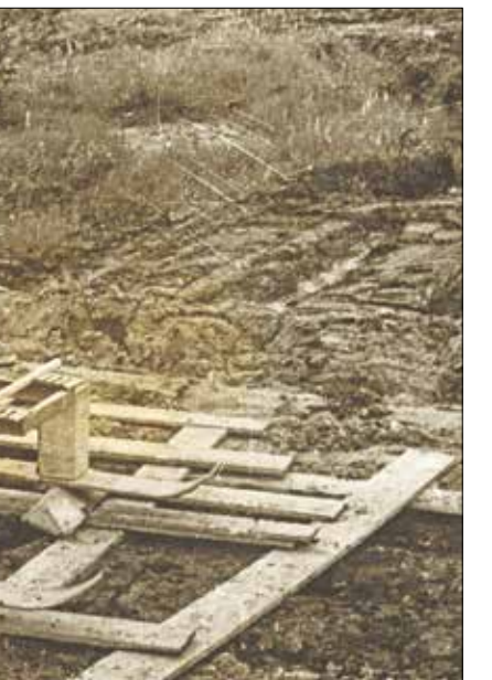
Einsinkversuche für Panzerketten an der damaligen TH Dresden. (Quelle: Nachlass Eberan von Eberhorst, R., Berichte und Untersuchungen, 1943–1944, v. Nr. 04, 2. Bericht Spezifischer Bodendruck u. Einsinktiefe, Institut für Kraftfahrwesen der Technischen Hochschule Dresden, 22. November 1943, Trittplatten-Meßgerät mit Beton-Zusatzgewichten.)
