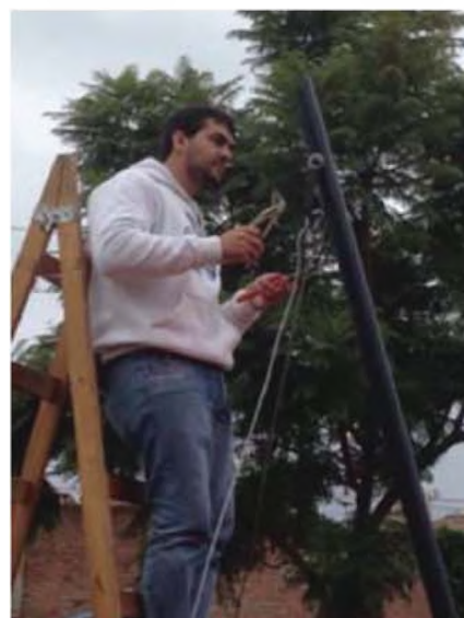
Figura 11: Anclaje para tensores y vinculaciones a la columna metálica. Fuente: elaboración propia
