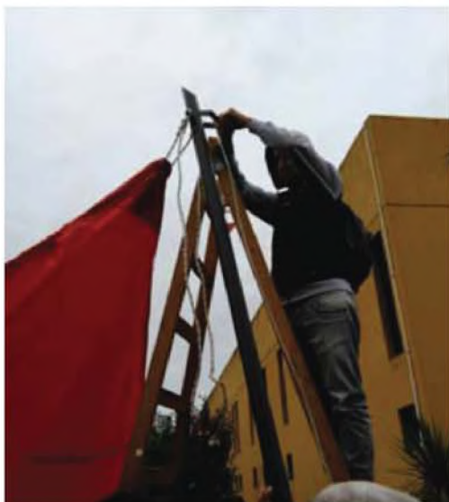
Figura 8: Colocación de los tensores de acero. Fuente: elaboración propia
