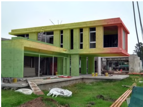
Figura 3. Obra terminada. Los colores identifican las deformaciones
