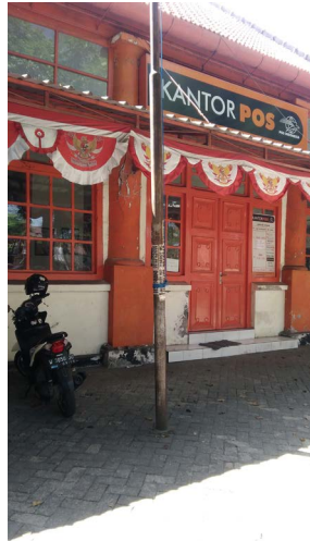
Foto 15. Fasad Bangunan Kantor Pos Gresik (Sumber: Putranto)
