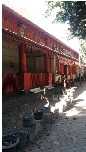
Foto 13. Fasad Bangunan Kantor Pos Gresik (Sumber: Putranto)
