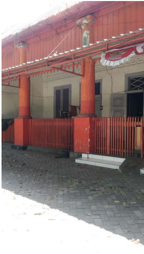
Foto 14. Fasad Bangunan Kantor Pos Gresik (Sumber: Putranto)
