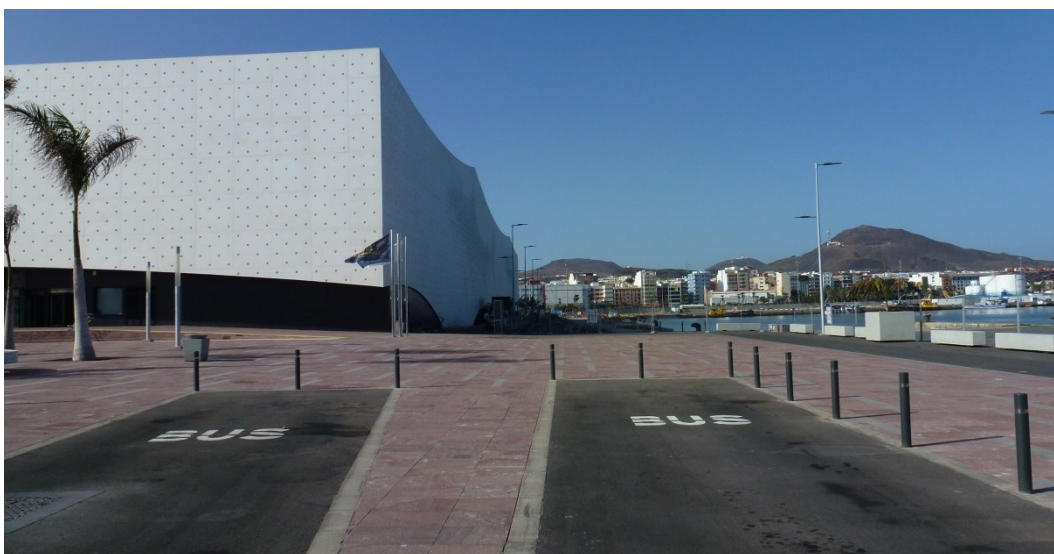
Fig. 206: Evolución de las obras de la avenida de los Consignatarios en su 2ª fase.
