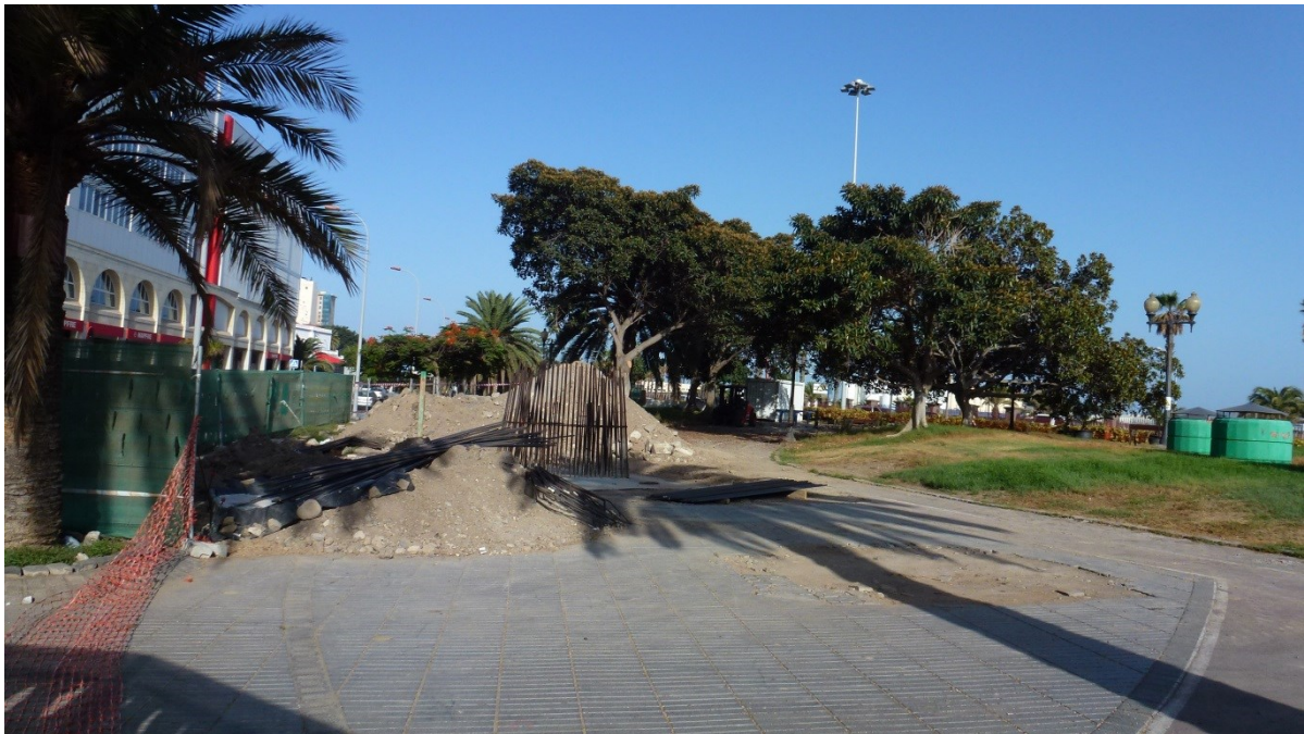
Fig. 233: (Arriba) Estado inicial de la zona a intervenir para la construcción de la pasarela Onda Atlántica, con 8 palmeras alineadas en dos ejes paralelos. (Abajo) Las 8 palmeras han desaparecido con el inicio de las obras.
