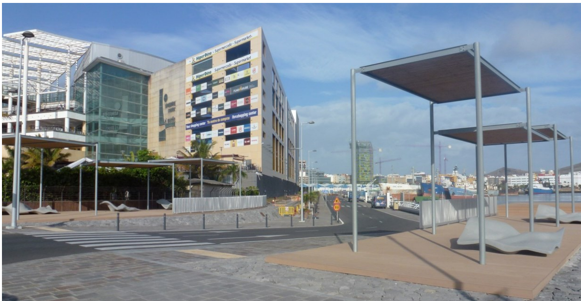
Fig. 202: Resultado de las obras de peatonalización del lado poniente de la avenida de los Consignatarios.
