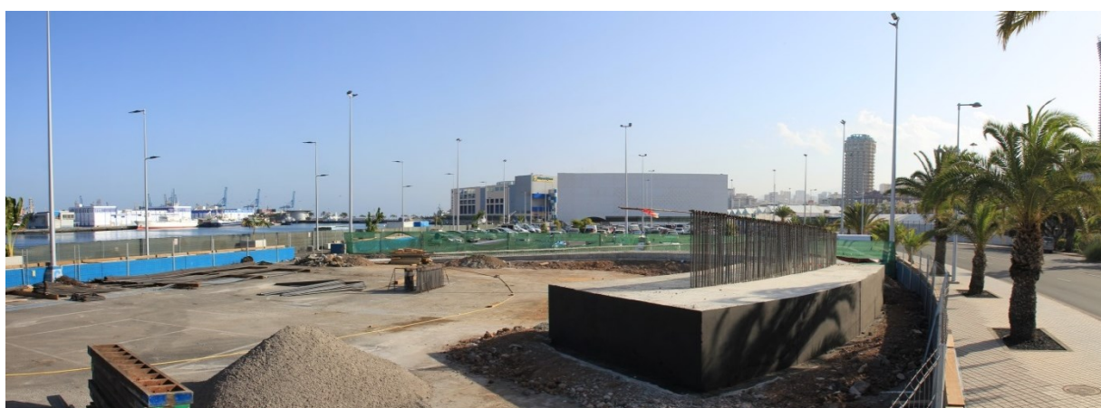
Fig. 226: (Arriba) Superficie del parking Sagulpa a derribar para comenzar las obras de la pasarela Onda Atlántica. (Abajo) Panorámica del área ocupada para las obras de la pasarela Onda Atlántica. A la derecha de la imagen inferior se puede observar la estructura del arranque de la pasarela.
