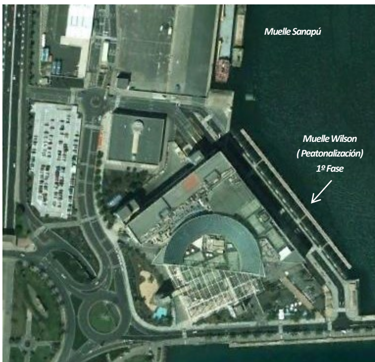
Fig. 200: Vista aérea de la intervención de la 1º fase de peatonalización. E 1/3.000.
