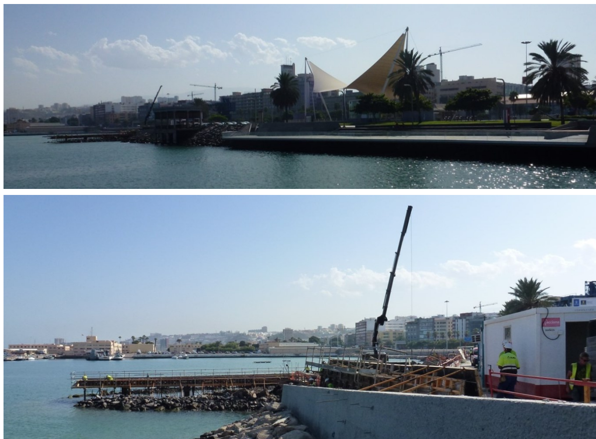
Fig. 253: Avance de las obras del voladizo de la 2ª fase del frente marítimo. 2018.
