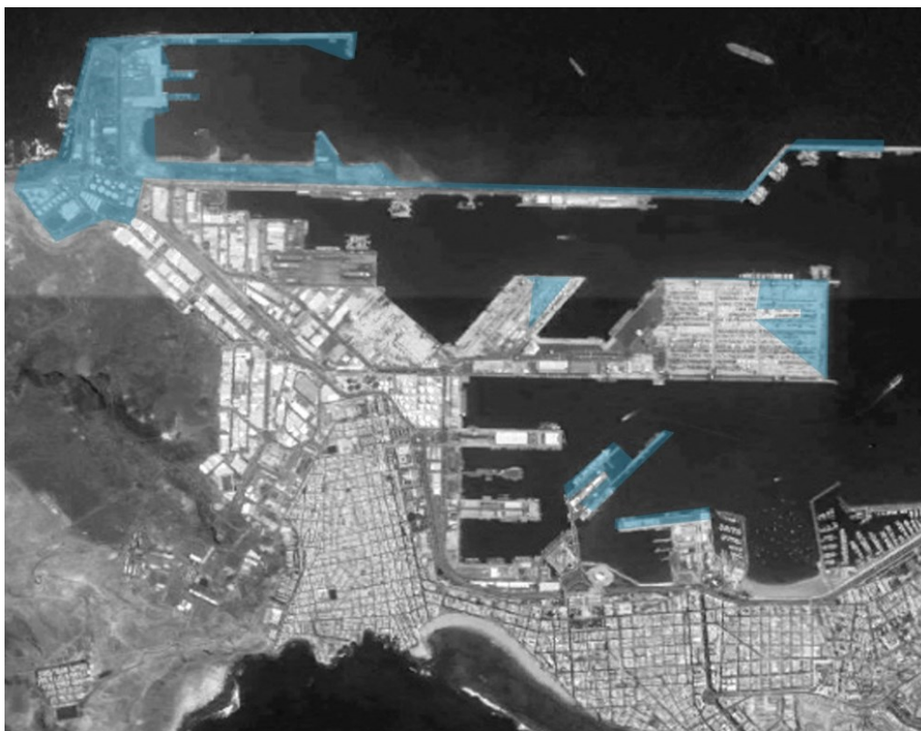
Fig. 198: Esquema del aumento de las superficies portuarias. (Arriba) El puerto en 1998. (Abajo) En azul se representa el incremento de las superficies destinadas a áreas portuarias con respecto a 1998. E 1/32.500.
