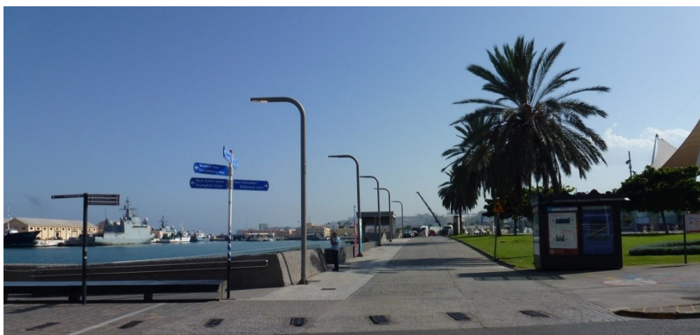
Fig. 247: Evolución de la construcción de la entrada del frente marítimo.
