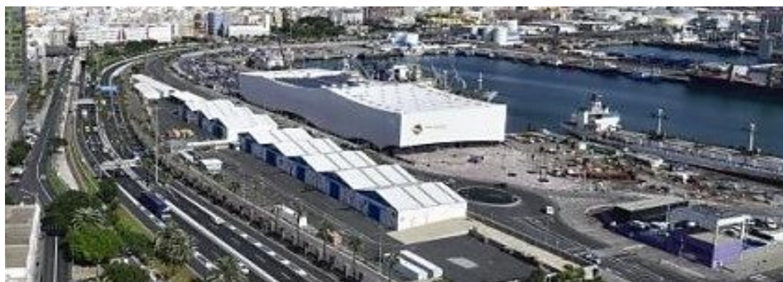
Fig. 325: Perspectiva en isométrica de la construcción del Acuario Poema del Mar. 2013-2017.
