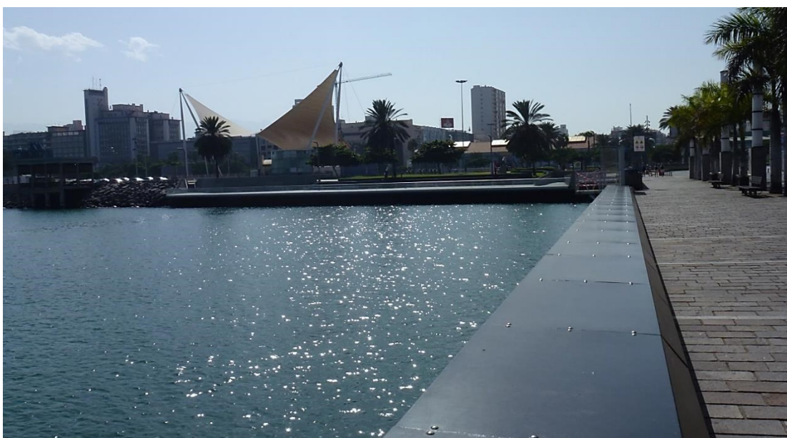
Fig. 244: Evolución de las obras de la 1ª fase del frente marítimo correspondiente al mirador. 2010-2016.
