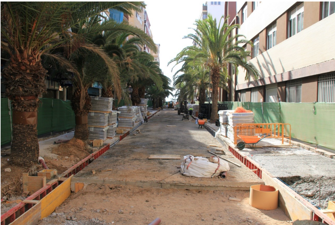
Fig. 239: (Arriba) Estado inicial de la calle Luis Morote. (Centro) Cierre de la vía para el inicio de las obras de peatonalización de la 3ª Fase. (Abajo). Estado de las obras de peatonalización de la 3ª Fase.
