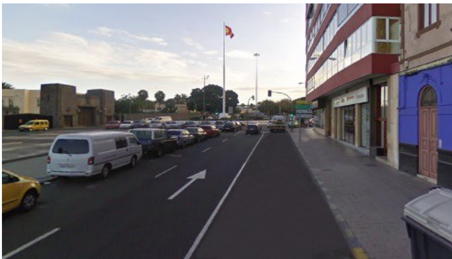
Fig. 268: Estado inicial del acceso a Mesa y López.
