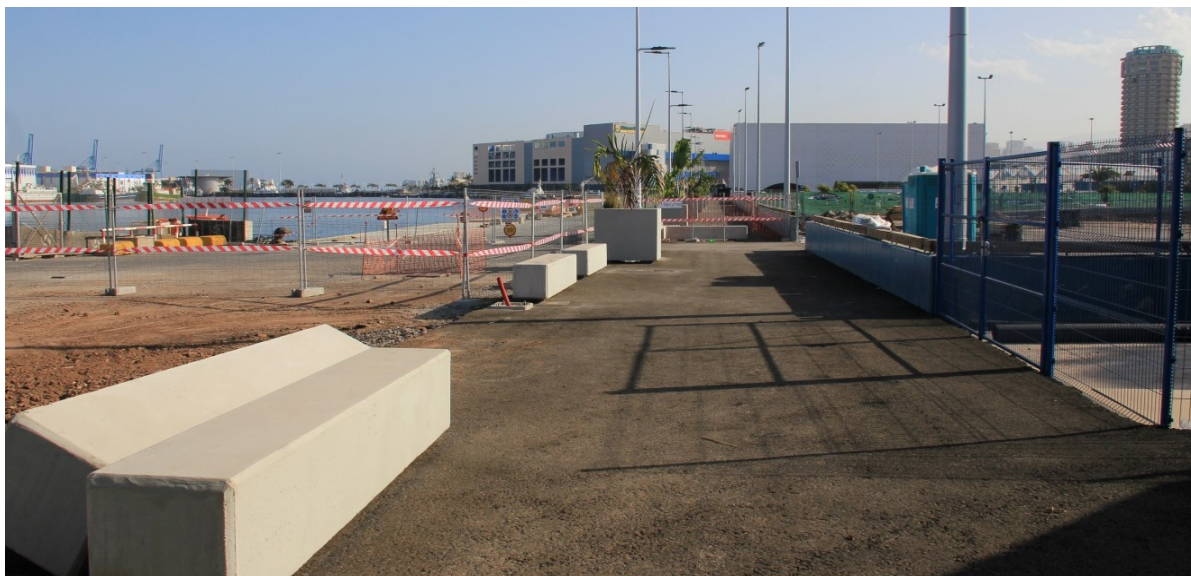
Fig. 224: Cerramiento vertical en el lado poniente del aparcamiento de Salgupa. 2018.
