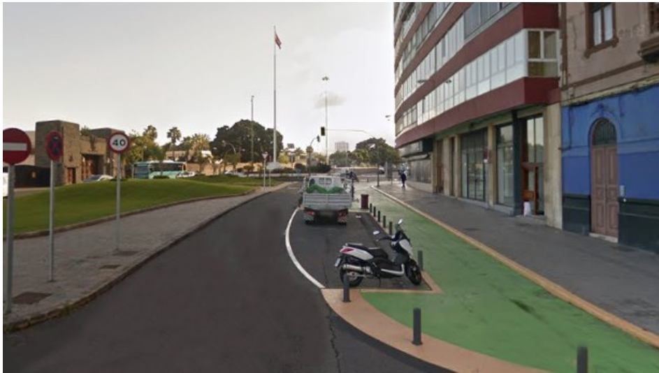
Fig. 269: Primer tramo de la actuación de la peatonalización de Mesa y López. 2015.
