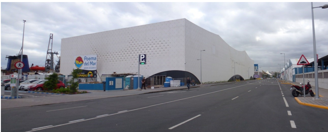
Fig. 327: (Arriba) Perspectiva norte de la parcela del Acuario Poema del Mar. (Abajo) Acuario construido.
