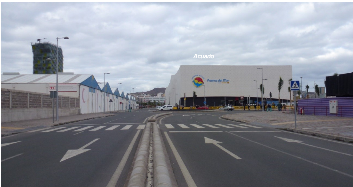
Fig. 203: Resultado de las obras de peatonalización del lado naciente.
