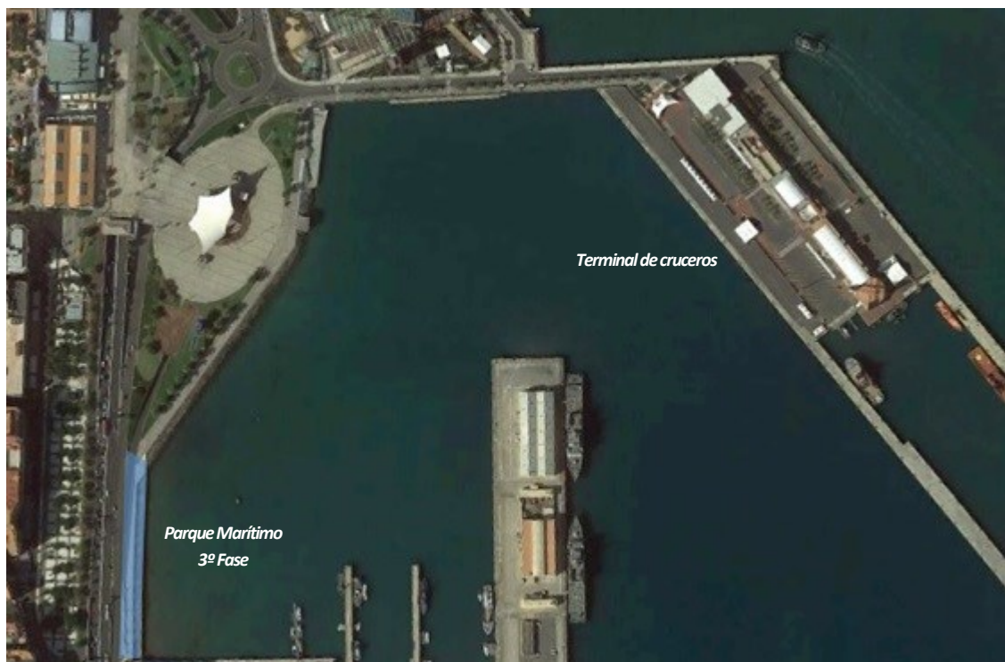
Fig. 254: Vista aérea del emplazamiento de la 3ª fase del frente marítimo. E 1/5.000.
