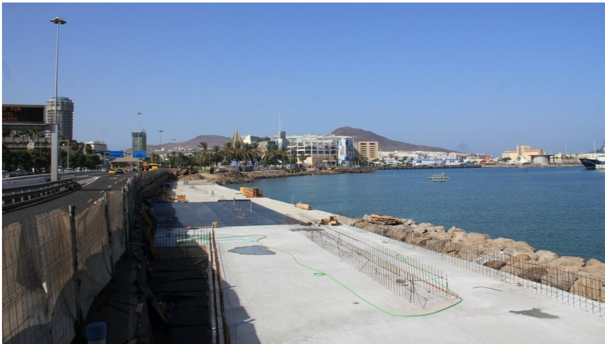
Fig. 256: Estado de las obras de la 3ª fase del frente marítimo de Las Palmas. 2018.
