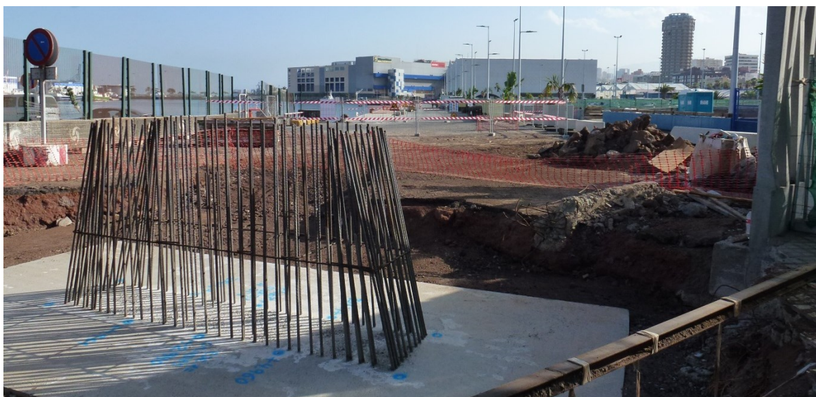
Fig. 232: Excavaciones para la cimentación de la pasarela Onda Atlántica. 2018.
