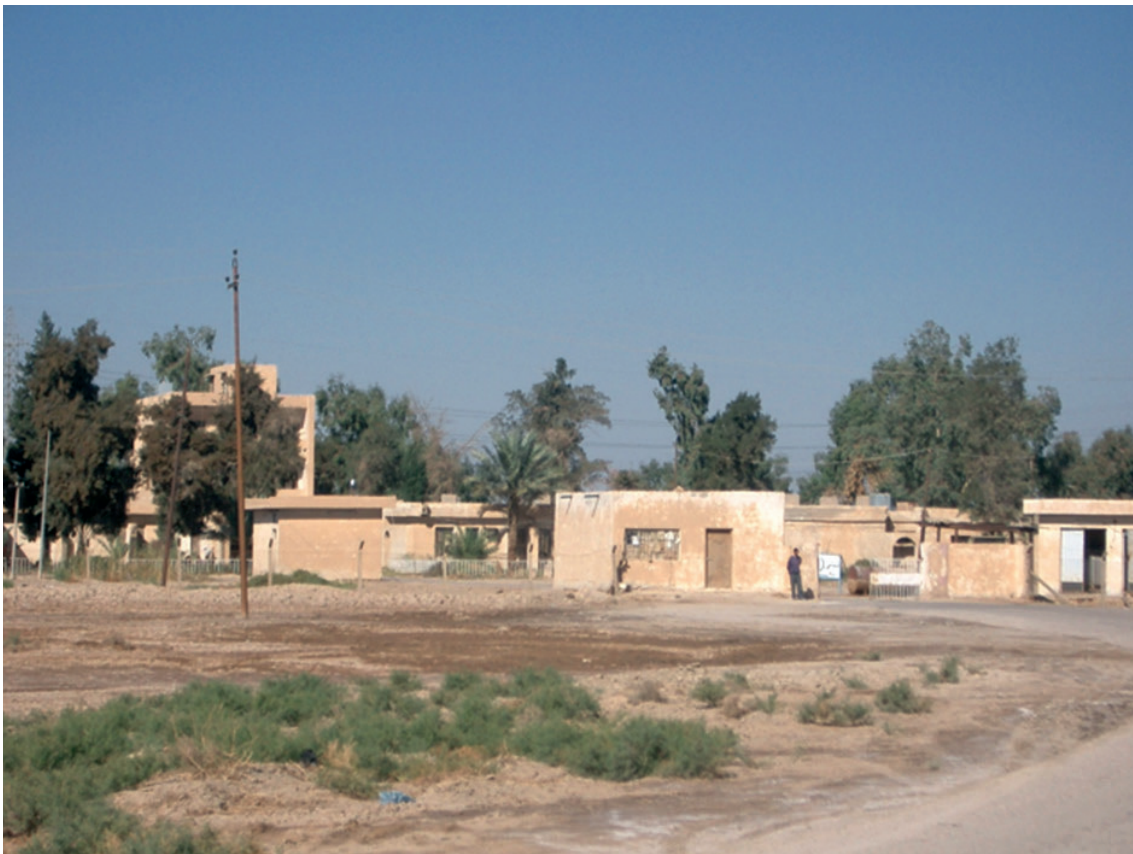
Fig. 33. Estado del que funcionaba como hospital de enfermedades infecciosas a nuestra llegada. Diwaniya agosto 2003.
