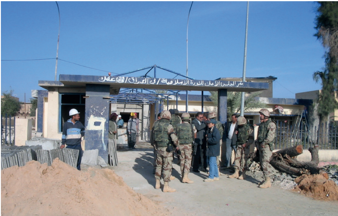
Fig. 22. Construcción de un centro de salud.
