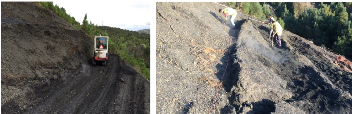
Figura 4.28: Vistas de la instalación de campo del cable de fibra óptica para medir temperatura.
