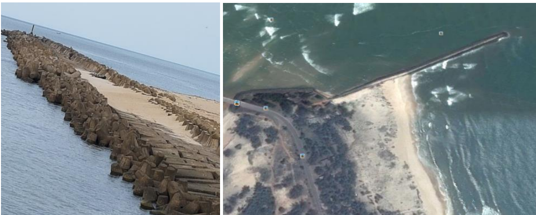
Hình 7. Cát bị giữ lại sau bờ kè nam, thậm chí tràn lên trên kè [7]
