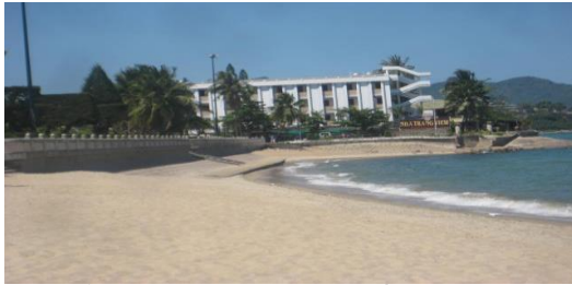
Bãi biển bị xói trong mùa gió Đông Bắc (ảnh T03/2013)
