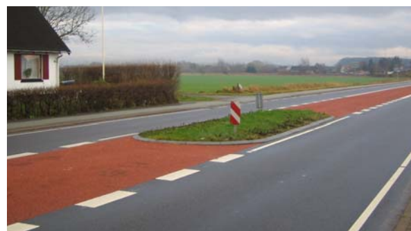
Figur 3. Helleanlæg i km 39.320.
