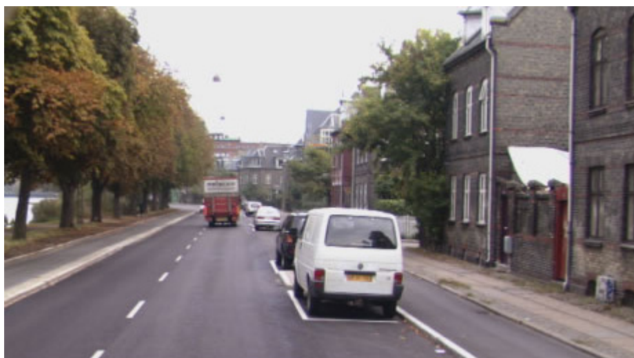
Figur 2. Forsøgsstrækningen på Øster Søgade i København efter udlægning af to-lags drænasfalt.
