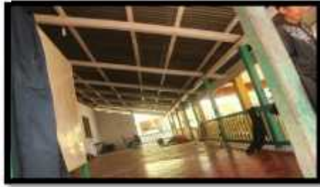
Foto 06 Teras Masjid Sumber : Dokumentasi, Sulfandi Nur 2018
